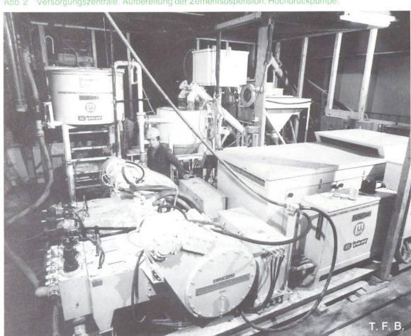
Abb. 2 Versorgungszentrale. Aufbereitung der Zementsuspension; Hochdruckpumpe.
