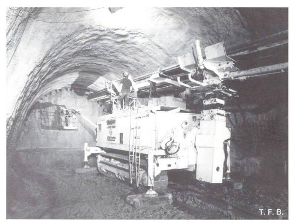
Abb. 1 Kalottenvortrieb im Lockergestein. Installation der Bohrmaschine für das Jet Grouting.
