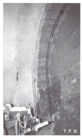
Abb. 8 Geschrämtes Ausbruchprofil.
