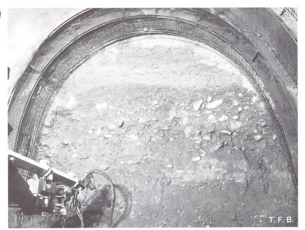
Abb. 6 Ortsbrust im Lockergestein, durch Schutzschirm gesichert. Einbau des Aussengewölbes in Etappen von 1 m.
