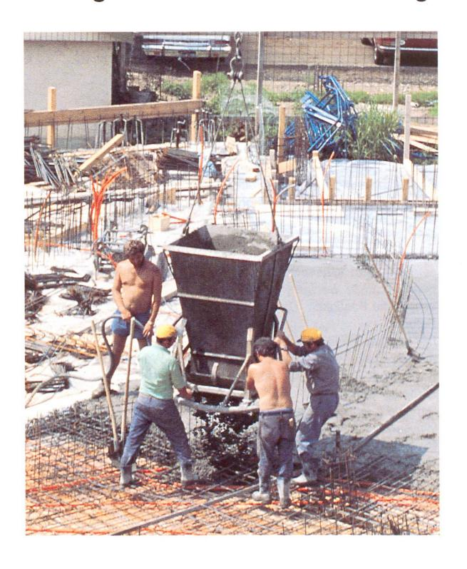
**Beton** entsteht durch Vermischen von *Zement* mit den *Zuschlagstoffen* Kies und Sand unter Zugabe von *Wasser*. Normalerweise enthält 1 m³ Beton 300–350 kg Zement, ungefähr 2000 kg Zuschlagstoffe und 130–200 l Wasser. Je nach Verwendungszweck können dem Beton noch *Zusätze* beigegeben werden (Zusatzmittel: etwa 0,5–10,0 kg/m³. Zusatzstoffe: etwa 5–50 kg/m³).
