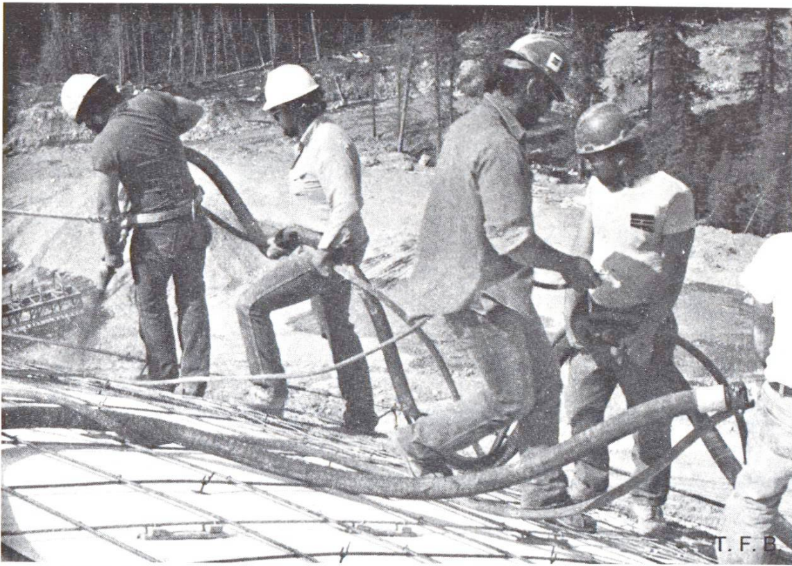
Abb. 8 Spritzbetonarbeiten, erste Schicht.
