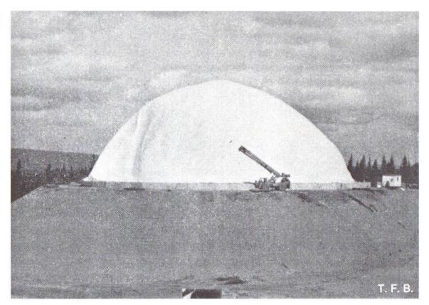
Abb. 4 Aufblasen einer Tragluftschalung (Kohlelager Hinton, Kanada).
