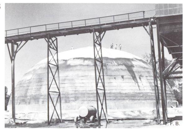
Abb. 7 Rundhalle ( $\emptyset = 37.8 \text{ m}, \text{ h} = 15.3 \text{ m}$ ) während der Spritzbetonarbeiten. Aufbringen der ersten Schicht. Die Tragluftschalung ist begehbar.
