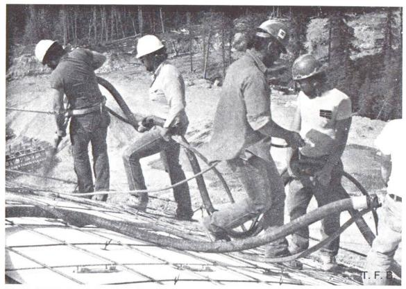
Abb. 8 Spritzbetonarbeiten, erste Schicht.
