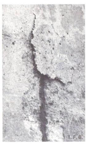
Abb. 5 Aufwölbung und Abplatzung infolge Korrosion der Armierung.
