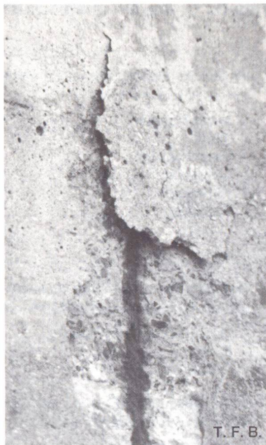
Abb. 5 Aufwölbung und Abplatzung infolge Korrosion der Armierung.
