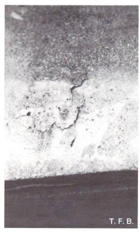
Abb. 4 Aufwölbung. Die Schadenursache ist hier von blossem Auge noch nicht erkennbar.
