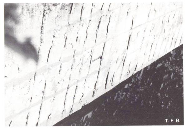
Abb. 6 Rostschäden an Balkonbrüstung infolge fortgeschrittener Karbonatisierung.
