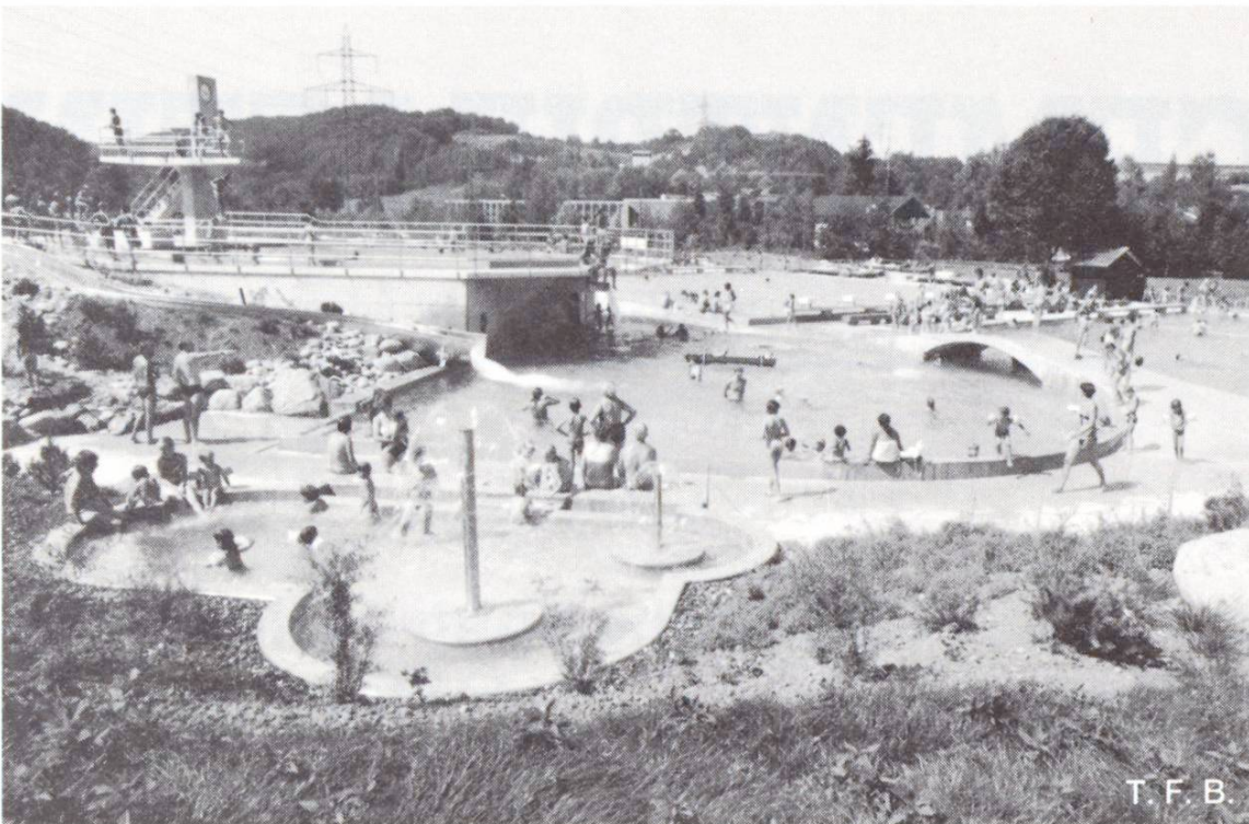
Abb. 1 Ansicht Schwimmbad Birmensdorf. Sprungbecken (erhöht), Nichtschwimmerbecken und Sprudelbank mit Wasserpilzen (im Vordergrund).
