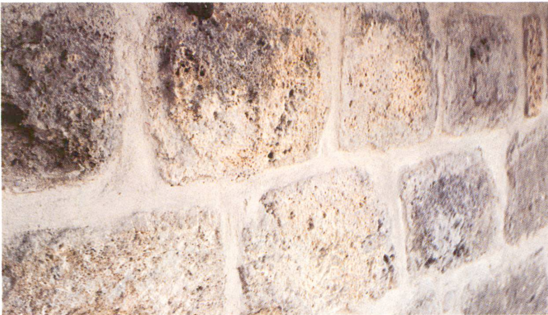
Abb. 8 Der Farbton des Mörtels ist auf den Tuffstein abgestimmt. Als Mörtelsand wurde eine ausgewählte Mischung von Brechsand aus dem Kalksteinbruch Egerkingen angewendet. Wichtig ist der dichte, rissfreie Anschluss des Stopfmörtels rund um die Quader.
