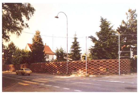
Abb. 3 Abschirmung eines Privatgrundstücks gegen eine stark befahrene Strassenkreuzung. Typ L aus Elementen von 50×20×60 cm und 50 kg Gewicht.
