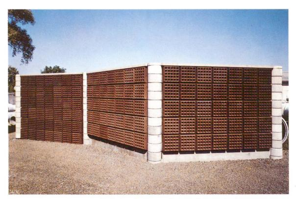
Abb. 10 Faverit-F. Faltwand für flexible Linienführung im Grundriss. Tragend sind Stahlrohrstützen auf Einzelfundamenten im Abstand von 3,93 m. Der Wandaufbau erfolgt mit horizontalen Lärmschutzelementen (h=50 cm), die an ihren Stirnseiten mit Betonringen von halber Elementhöhe versehen sind.
