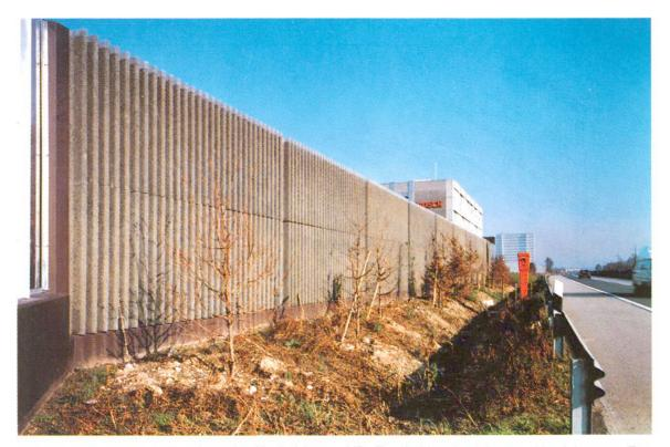
Abb. 8 Lärmschutzwand entlang der N1 bei Lonay VD. Zweifarbige Ausführung, Wandelemente Typ Structa (Höhe variabel, max. 5 m lang). Hohe Schallabsorption durch Rippen- oder Spundwandstruktur. Zur sauberen Anböschung wird ein Fundamenthals angeordnet. Anstatt in Ortsbeton kann er als Schürze des untersten Elements vorfabriziert werden.
