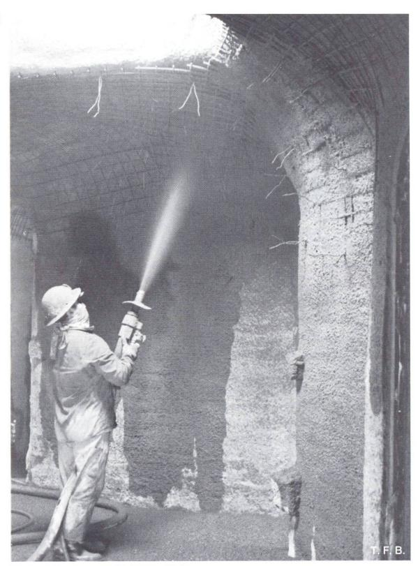
Abb. 5 Auftrag der zweiten Spritzbetonschicht.
