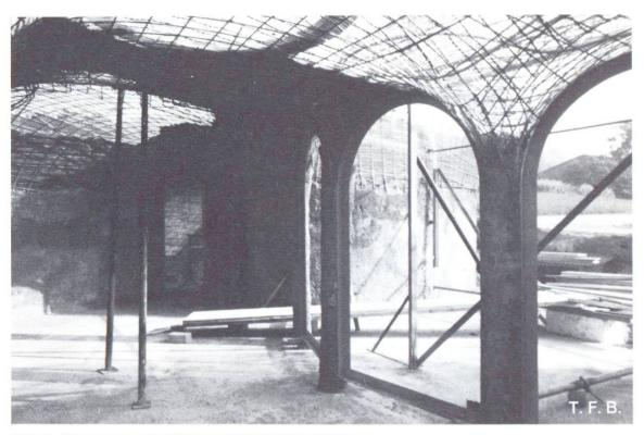
Abb. 4 Etappenweise Ausführung der Spritzbetonarbeiten.
