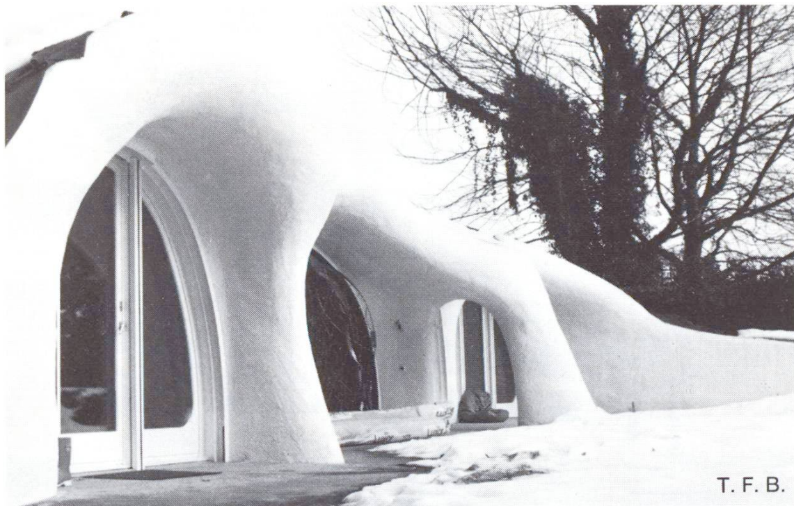
Abb. 8 Aussenisolation aus Polyurethan, das gleichzeitig die endgültige Formgebung bewirkt. Farbanstrich der sichtbaren Teile.
