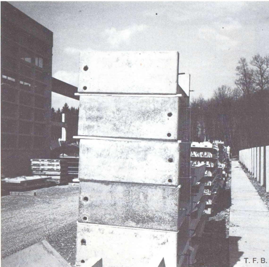
Abb. 4 Gleiche Elemente – ungleiche Betonzusammensetzung.
