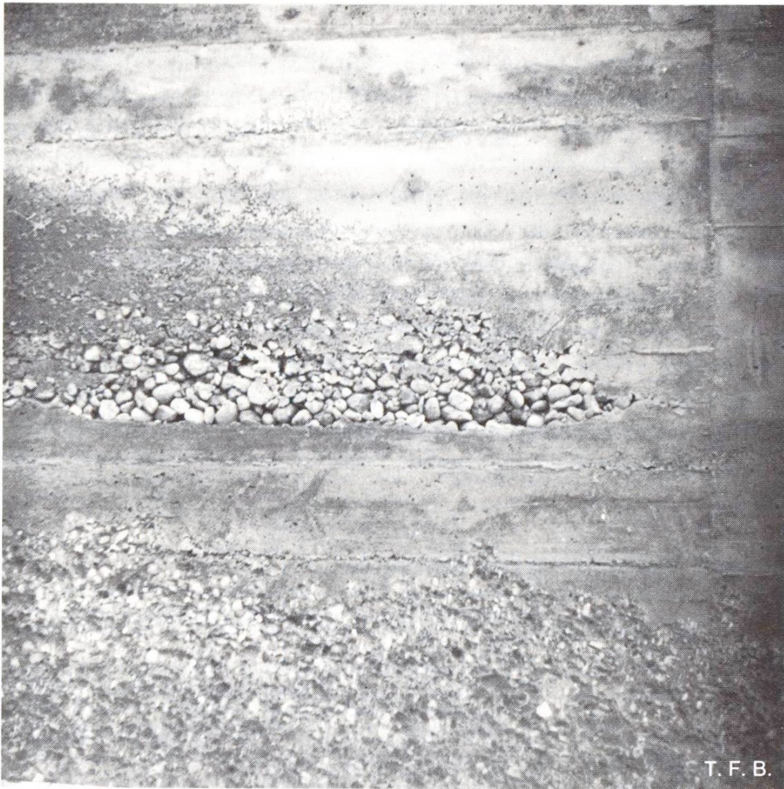
Abb. 4 Korngrössenentmischung im Beton.
