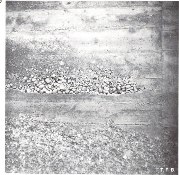
Abb. 4 Korngrössenentmischung im Beton.
