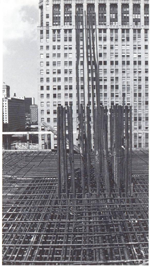
Abb. 4 Armierung einer Hauptstütze und ihrer Strebe zur Scherwand im 9. Boden.
