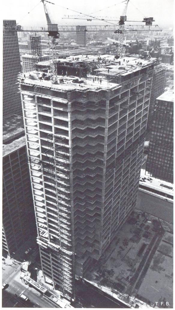
Abb. 9 Bau des Büroturmes in der Endphase, Februar 1983. Es fehlen noch 10 Stockwerke.
