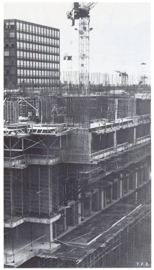
Abb. 3 Erstellung der kraftumlenkenden Zwischenwände im 14. Geschoss. Die Auskragung wird vorerst von einer Stahlkonstruktion getragen.
