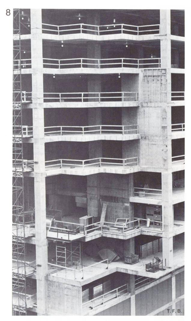
Abb. 7 Übersicht über die Zwischenwände vom 9. bis 15. Boden. Die äusseren Scheinstützen mit Hängerfunktion und die entsprechenden Erweiterungen der Bodenplatten 10. bis 12. wurden nachträglich erstellt.
