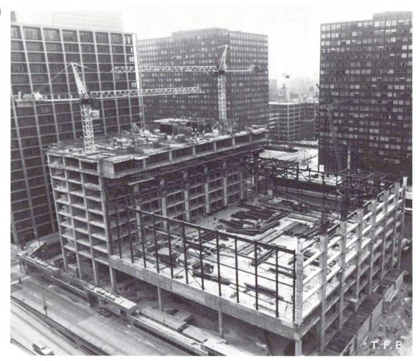
Abb. 8 Übersicht der Baustelle mit Turm I bis zum 9. Boden und der grossen Börsenhalle, die mit ihren 3700 m² mehr als die Hälfte des Grundstückes einnimmt.
