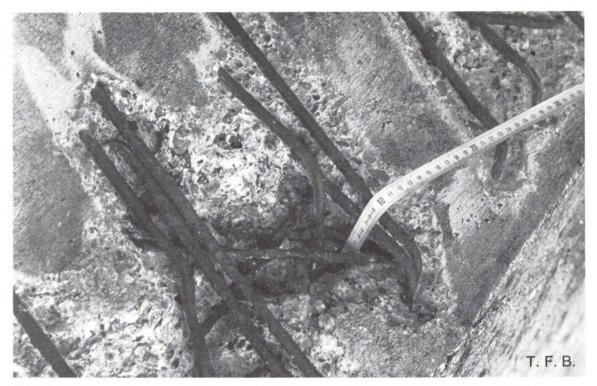
Abb. 5 Armierungskorrosion mit einem ursprünglich wasserreichen und sich entmischenden Beton.
