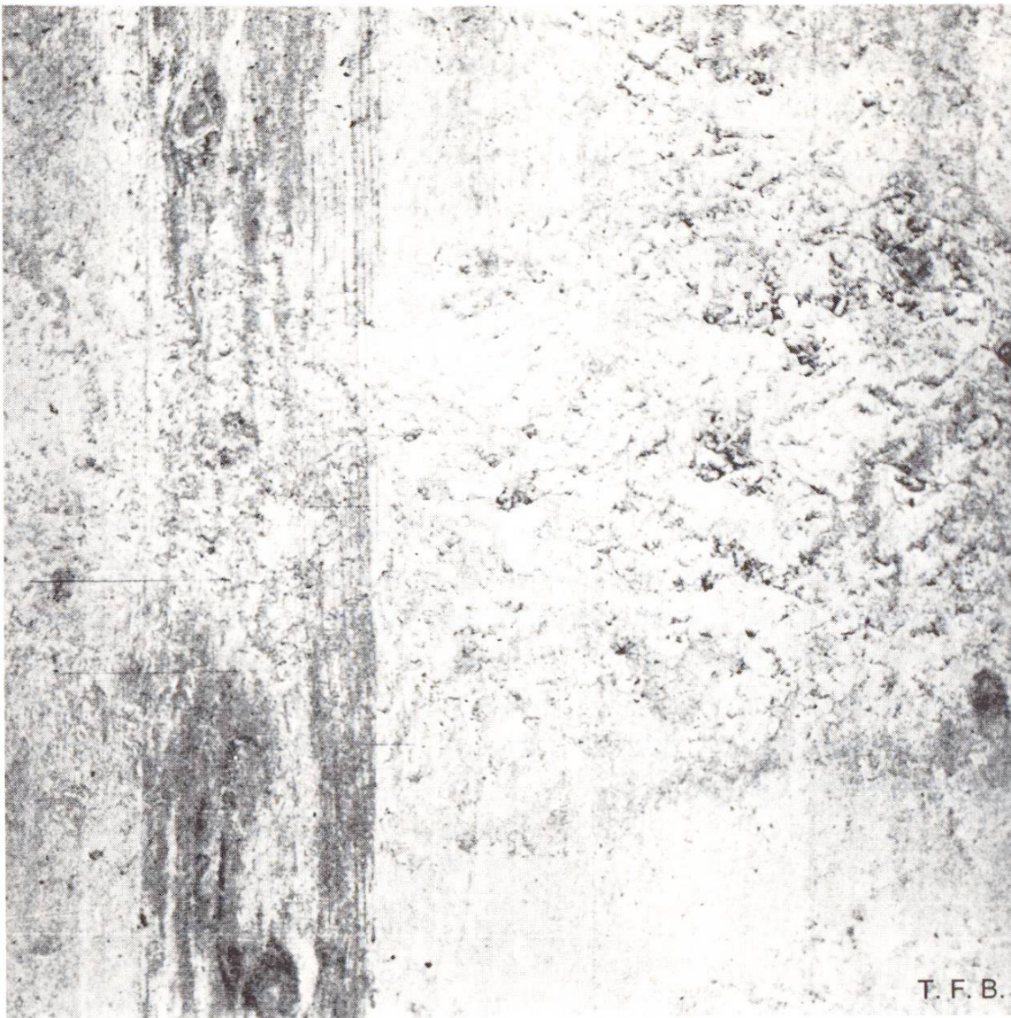
Abb. 3 Entmischung eines für guten Sichtbeton ungeeigneten Betons mit zu geringem Mörtelanteil. Man erkennt mangelhafte Verdichtung und verbleibende Hohlräume.
