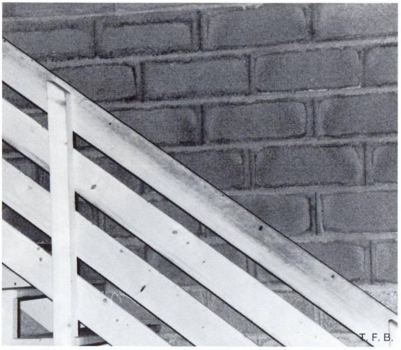
Abb. 12 Beton-Sichtmauerwerk in Kombination mit einfacher Holzkonstruktion.
