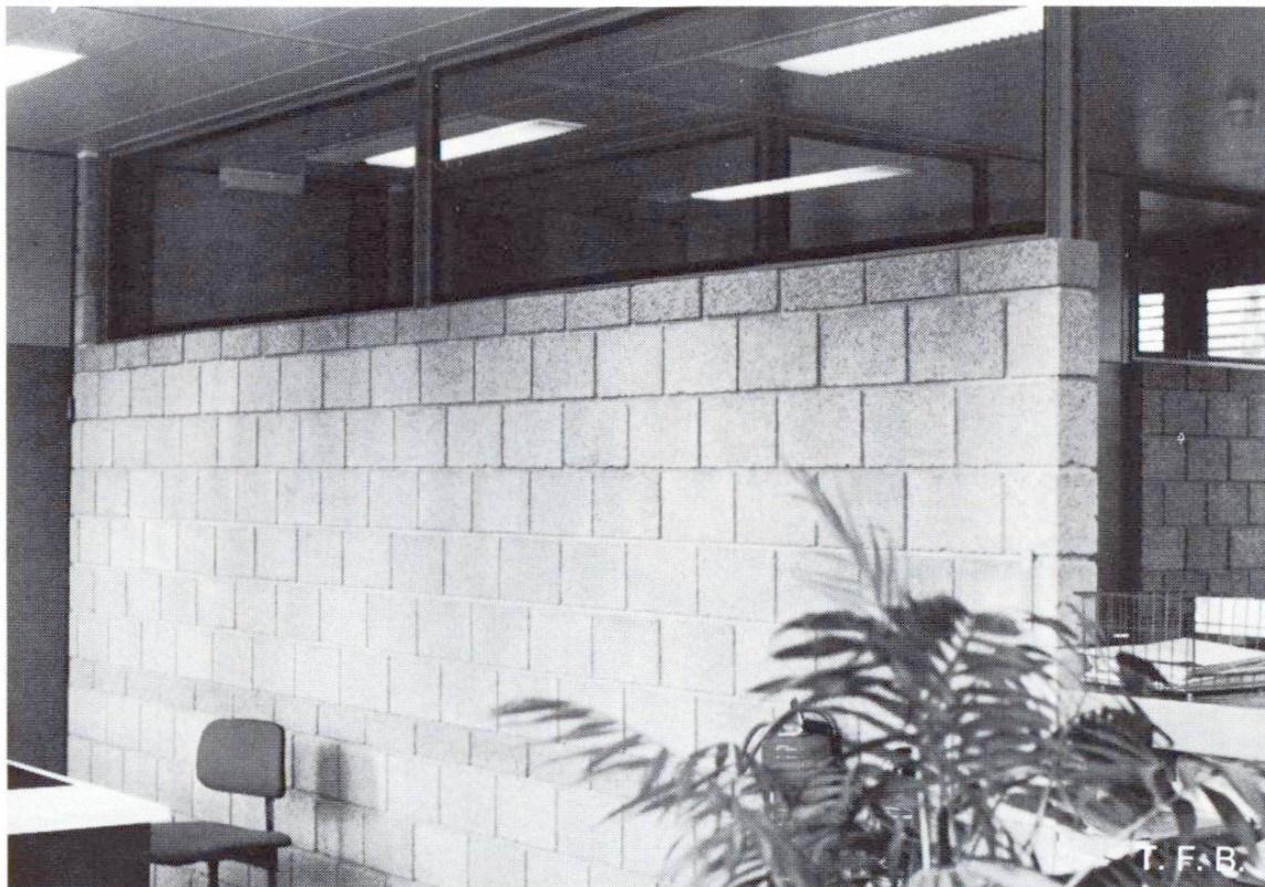
Abb. 14 Exakte Aufmauerung kombiniert mit Stahl-Fensterrahmen.
