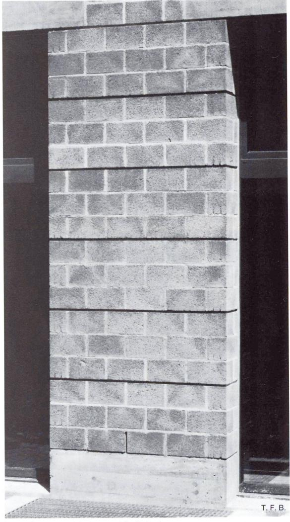
Abb. 8 Sichtmauerwerk in einem speziellen Verband.
