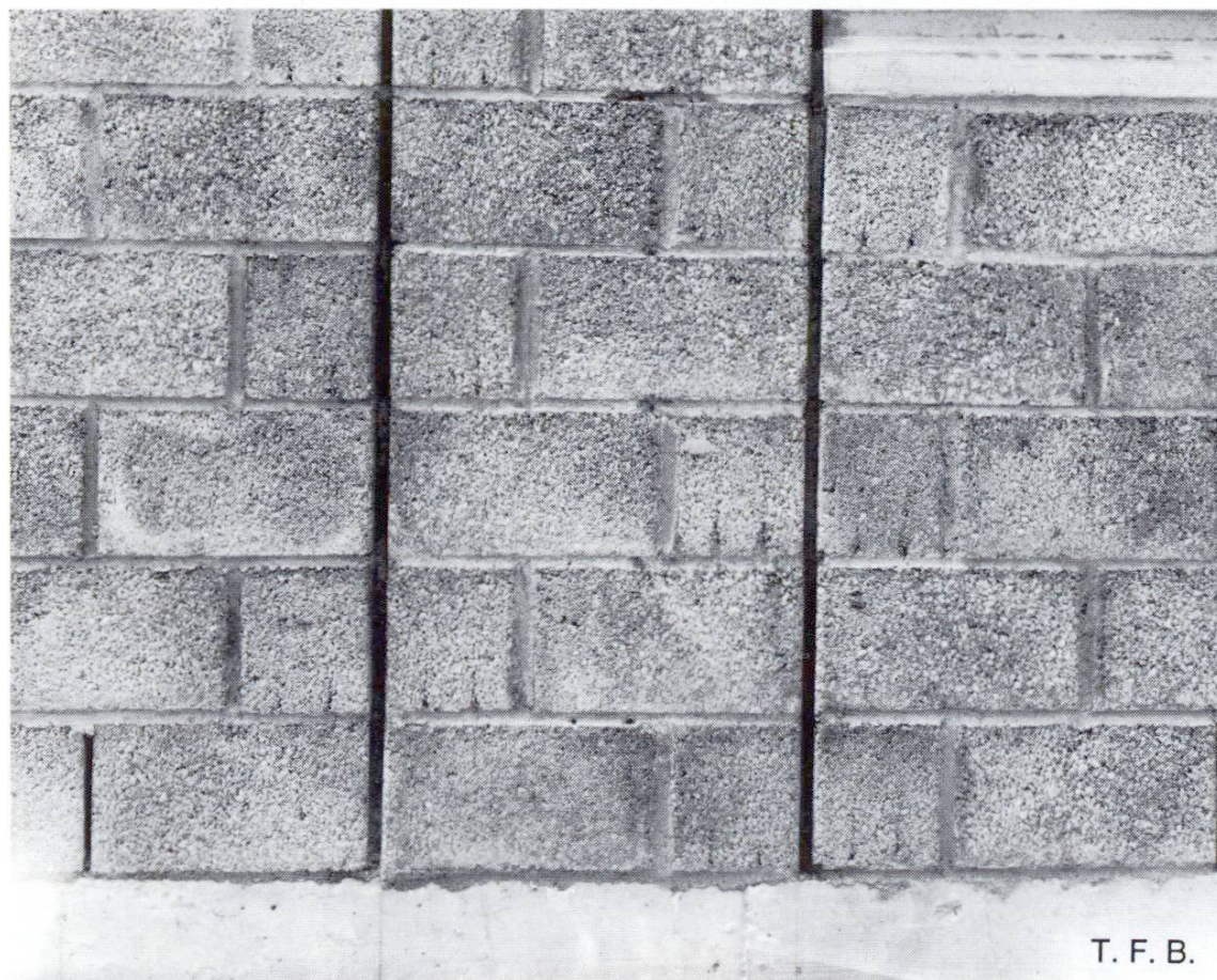
Abb. 10 Beton-Sichtmauerwerk mit einer verdünnten Dispersion gestrichen.
