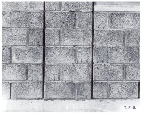
Abb. 10 Beton-Sichtmauerwerk mit einer verdünnten Dispersion gestrichen.
