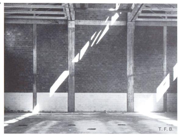
Abb. 6 Beton-Sichtmauerwerk in einem Industriebau.
