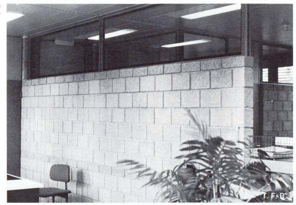
Abb. 14 Exakte Aufmauerung kombiniert mit Stahl-Fensterrahmen.
