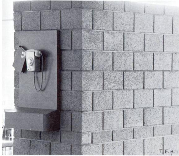
Abb. 11 Sichtmauerwerk mit Betonsteinen zur lockeren Raumteilung.
