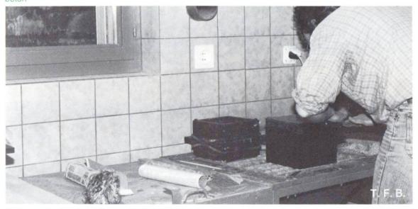
Fertigen eines Probewürfels in einer Plastikform
