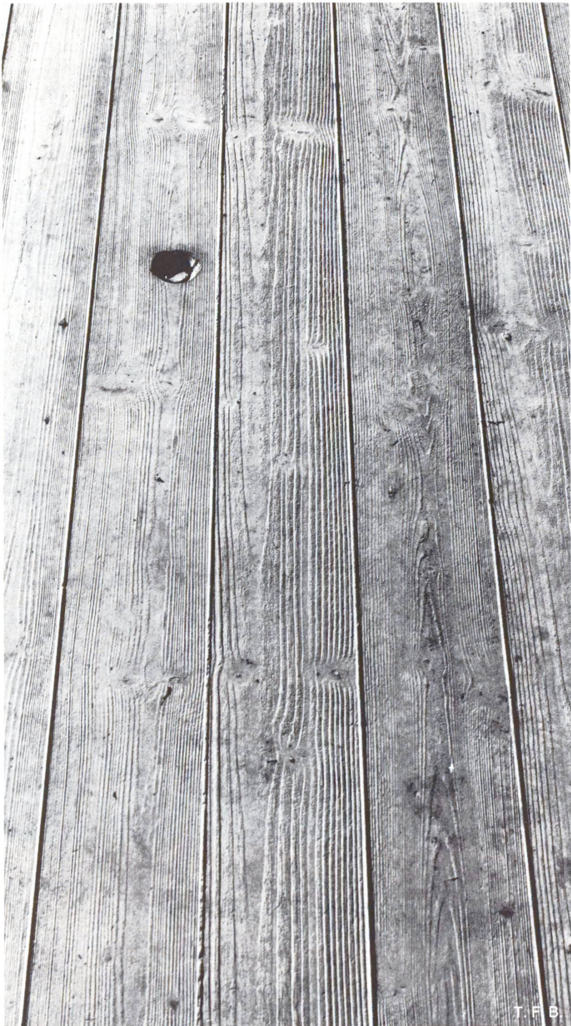
Abb. 2 Betonoberfläche aus der Schalung Abb. 1.
