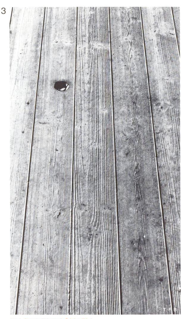
Abb. 2 Betonoberfläche aus der Schalung Abb. 1.
