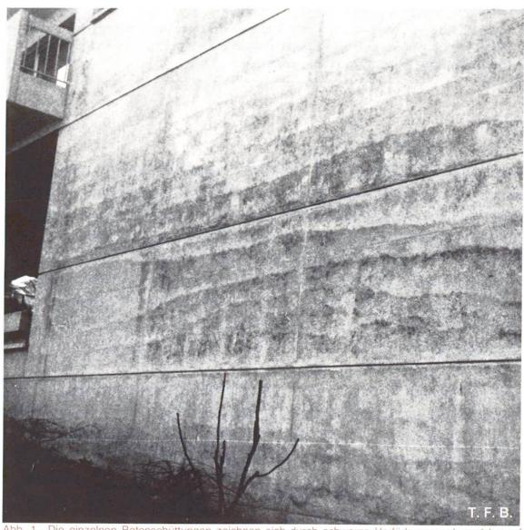
Abb. 1 Die einzelnen Betonschüttungen zeichnen sich durch schwarze Verfärbungen ab, welche auf Nachverdichtung im Stadium des Abbindebeginnes zurückzuführen sind.
