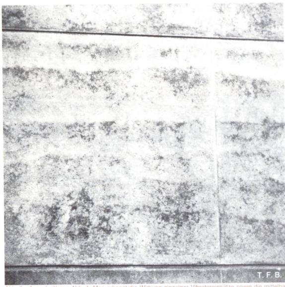
Abb. 3 Ausschnitt aus Abb. 1. Man erkennt die Wirkung einzelner Vibratoreinsätze sowie die mittelbar sich abzeichnende Schalungskonstruktion.
