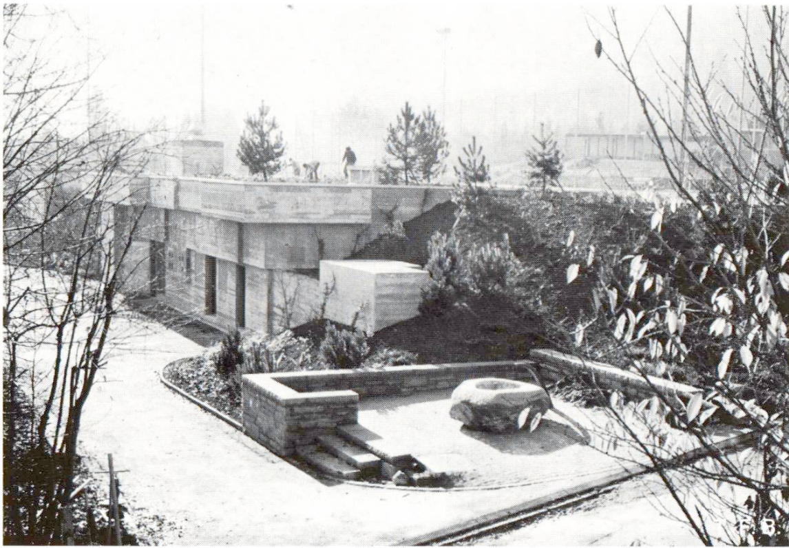
Abb. 12 Ansicht einer Fassade für ein Pumpwerk und Reservoir. Die architektonische Gestaltung in Sichtbeton deutet an, dass es sich um ein besonderes Schutzbauwerk handelt. Die abgedruckten Holzstrukturen und verschiedenen Grautöne widerspiegeln in der Feinstruktur der einzelnen Betonblöcke.
