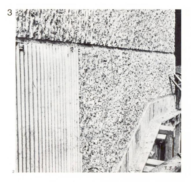
Abb. 5 Kombination Formen/Oberflächenstruktur bei einer kleinen Quellwasserfilteranlage im Wald. Nach einigen Jahren bekommt die strukturierte Sichtbetonoberfläche eine sympathische Patina durch Blütenstaub-Befall und Vermoosung.
