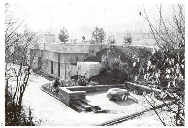
Abb. 12 Ansicht einer Fassade für ein Pumpwerk und Reservoir. Die architektonische Gestaltung in Sichtbeton deutet an, dass es sich um ein besonderes Schutzbauwerk handelt. Die abgedruckten Holzstrukturen und verschiedenen Grautöne widerspiegeln in der Feinstruktur der einzelnen Betonblöcke.
