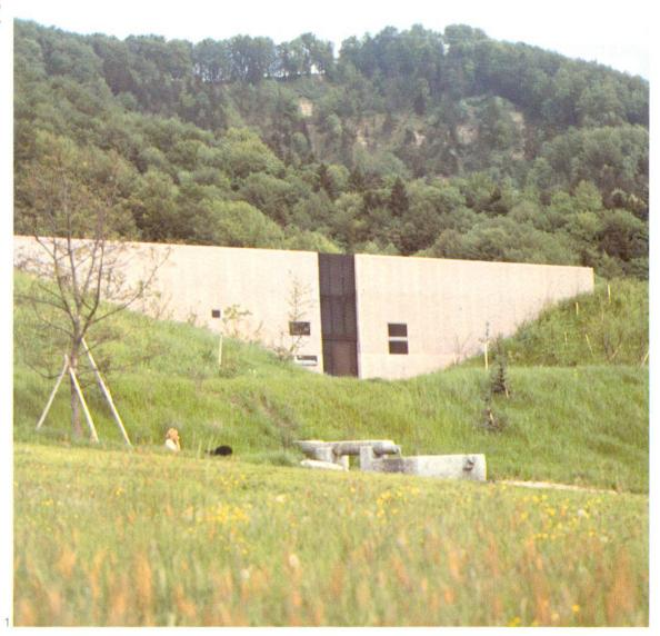
Abb. 1 Strukturierte Farbbetonfassade eines grösseren unterirdischen Behälters. Ein Versuch, den Farbton an die Umgebung des Uetliberghanges anzupassen.
