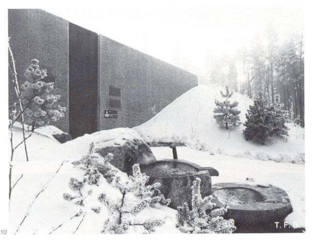
Abb. 9 Freundschaftliche Symbiose: Sichtbeton und Trinkwasser (siehe Cementbulletin 7/82). Geschliffene Oberfläche gibt dem Baustoff Beton ein natürliches Aussehen und gleicht einem Nagelfluhgestein.
