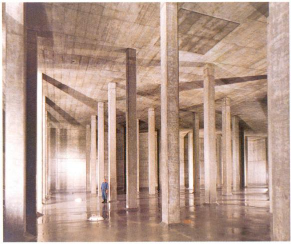
Trinkwasserreservoir in wasserdichtem Sichtbeton
