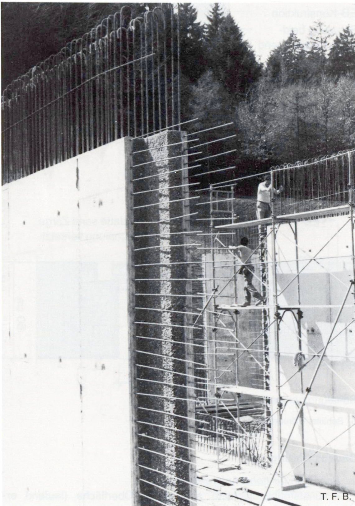
8. Detail Arbeitsfuge Wand
