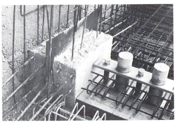
9. Detail Arbeitsfuge mit Dichtungsblech
