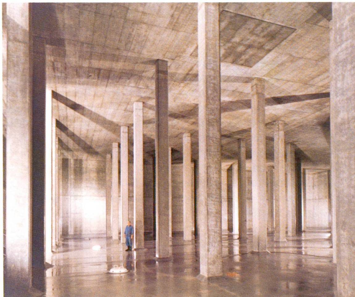
Trinkwasserreservoir in wasserdichtem Sichtbeton
