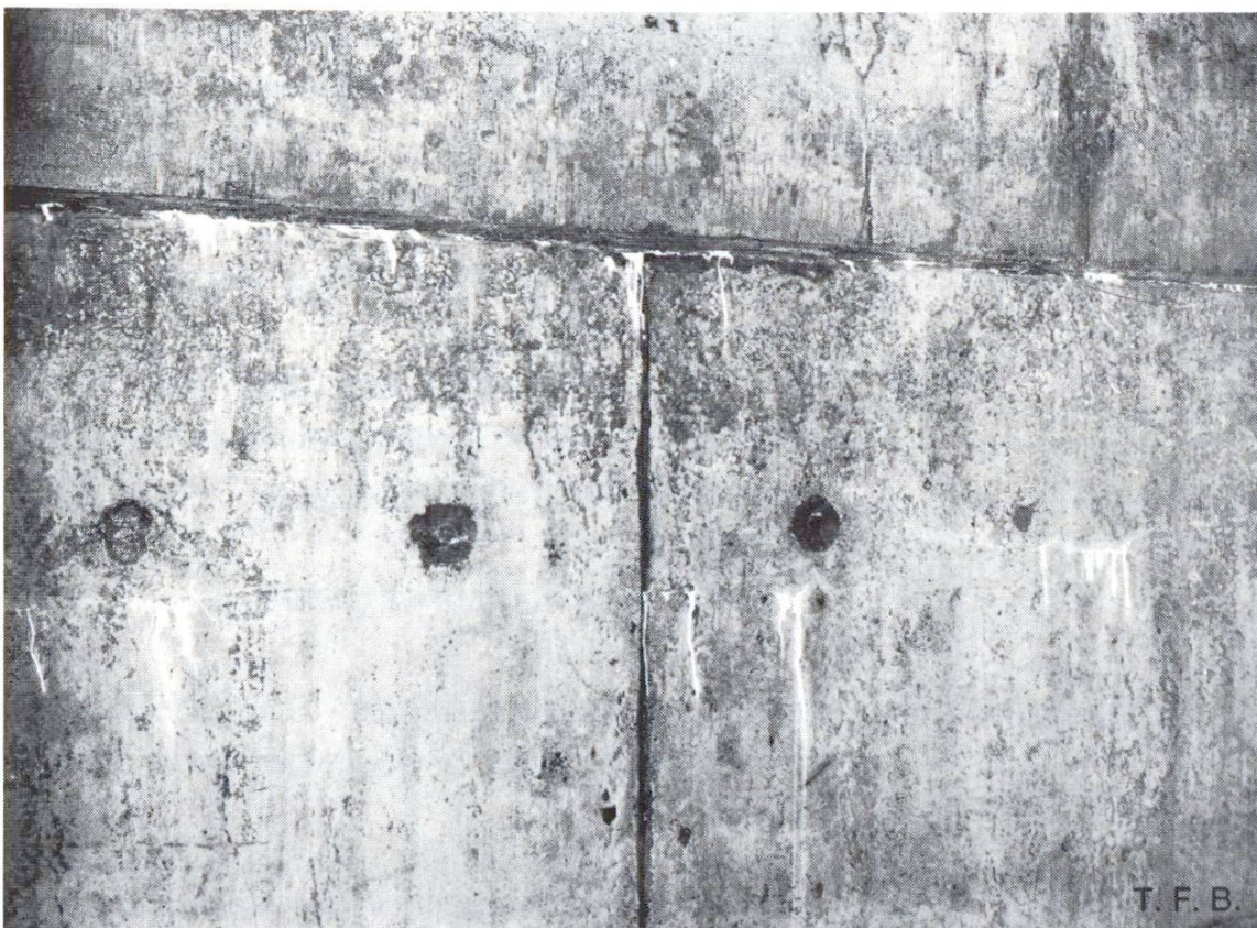
11. Versinterung Arbeitsfuge/Schwindrisse
