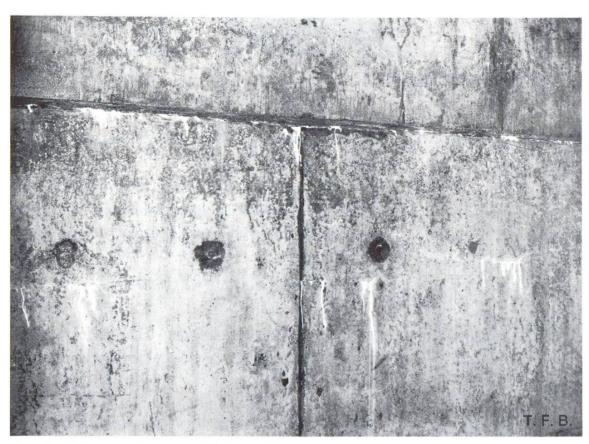
11. Versinterung Arbeitsfuge/Schwindrisse
