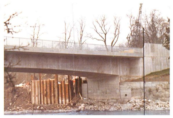
Abb. 4 Neubau Pont de Sierne I, Genf. Für die Brücke wurde Roche-Zement und für den Brückenkopf Eclépens-Zement verwendet (s. eingezeichneter Trennstrich). Es sind keine farblichen Unterschiede festzustellen.
