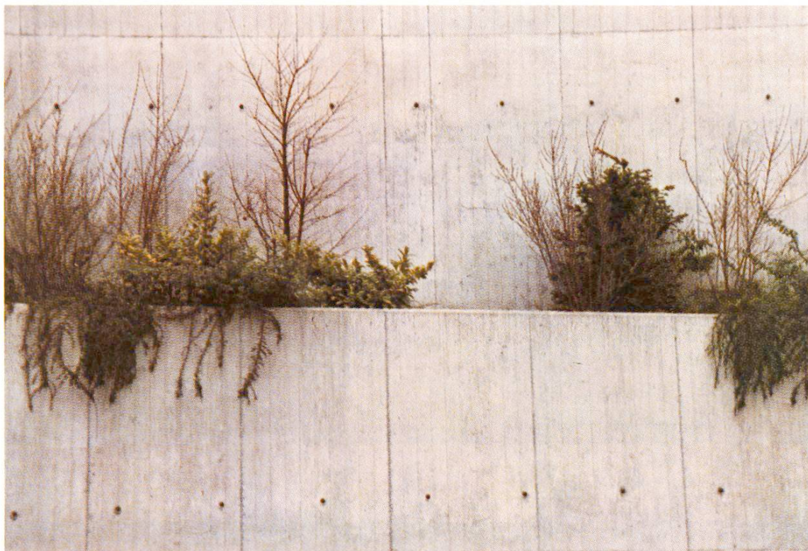
Abb. 5 Rampe de Vésenaz GE. Stützmauer mit Eclépens-Zement. Mit einer wasserdichten, kunststoff- vergüteten Schalung erhält man in der Regel einen sehr hellen, gleichmässigen Sichtbeton.
