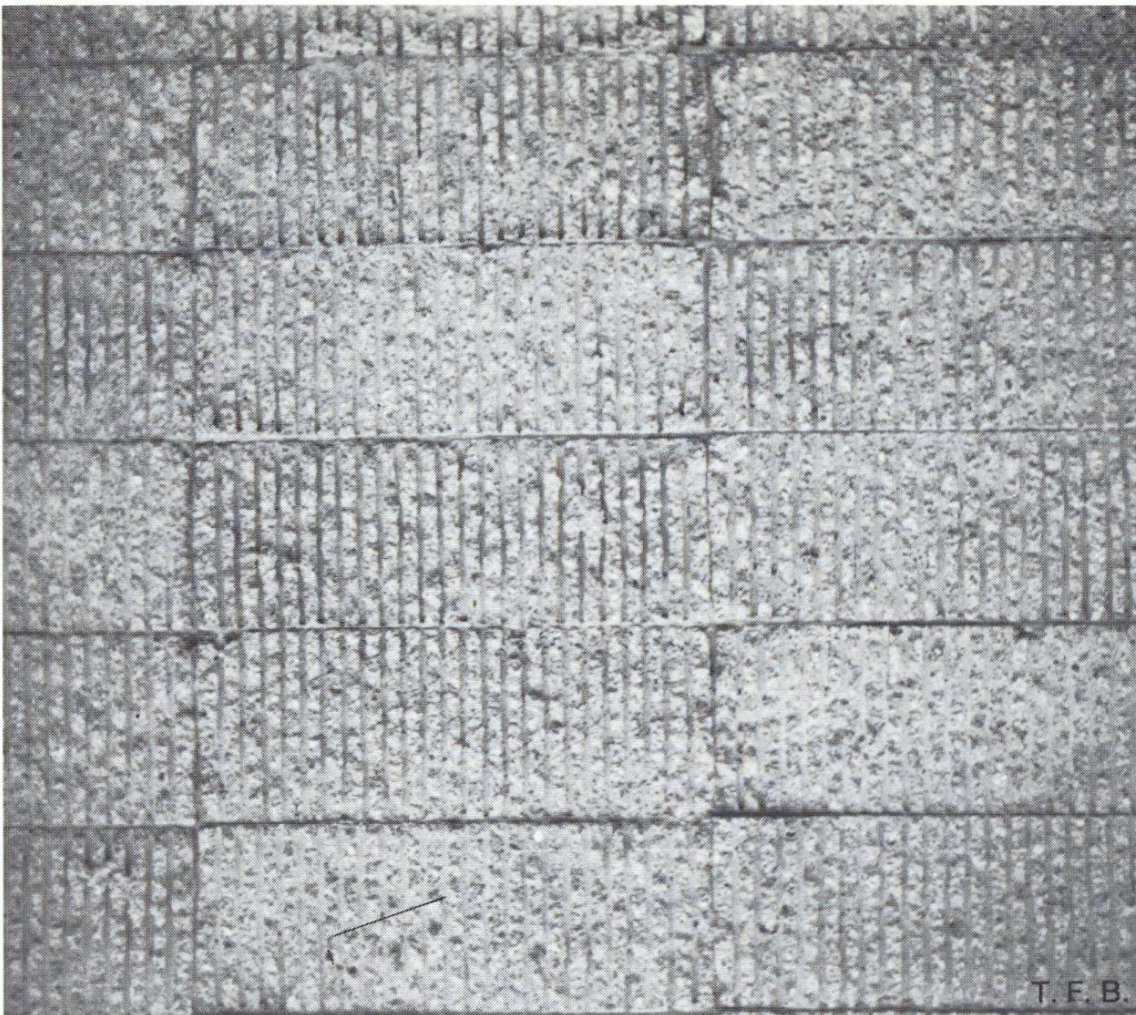
Abb. 8 Beispiel einer Oberflächenstruktur, welche mit Ortsbeton nicht realisiert werden kann.
