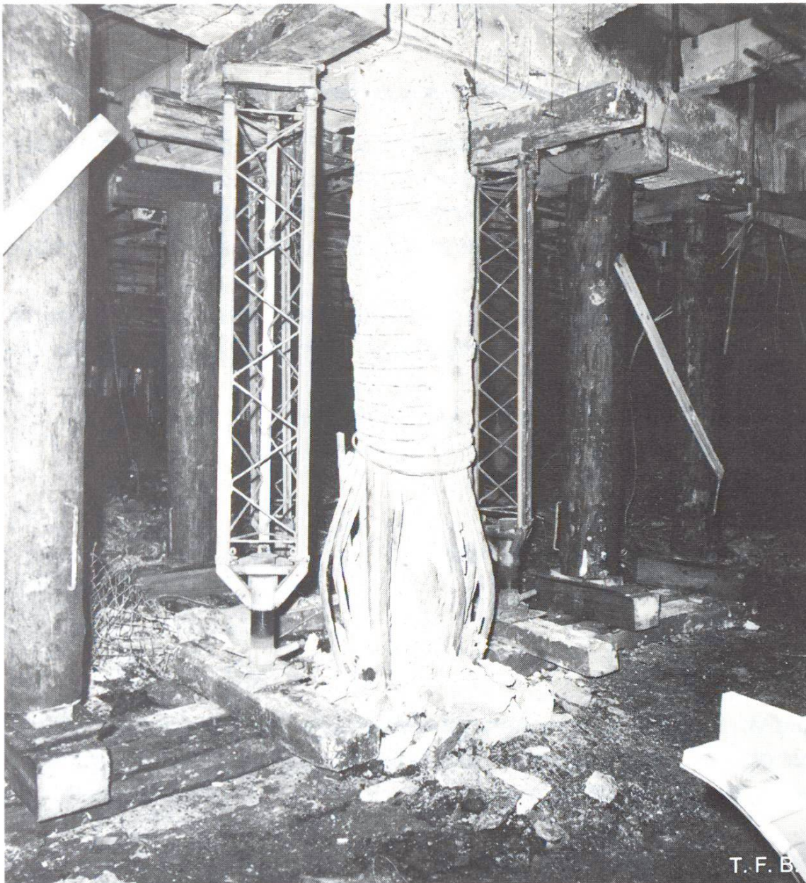
Abb. 1 Hochbelasteter Betonpfeiler nach Brandeinwirkung an der Grenze seiner Tragfähigkeit. Man erkennt, dass die Eisenüberdeckung an der Säule und am Unterzug gering war. Mit etwas mehr wäre der Zustand weniger kritisch geworden (Foto: Feuerwehr und Katastropheneinsatz – Lichtbildstelle).
