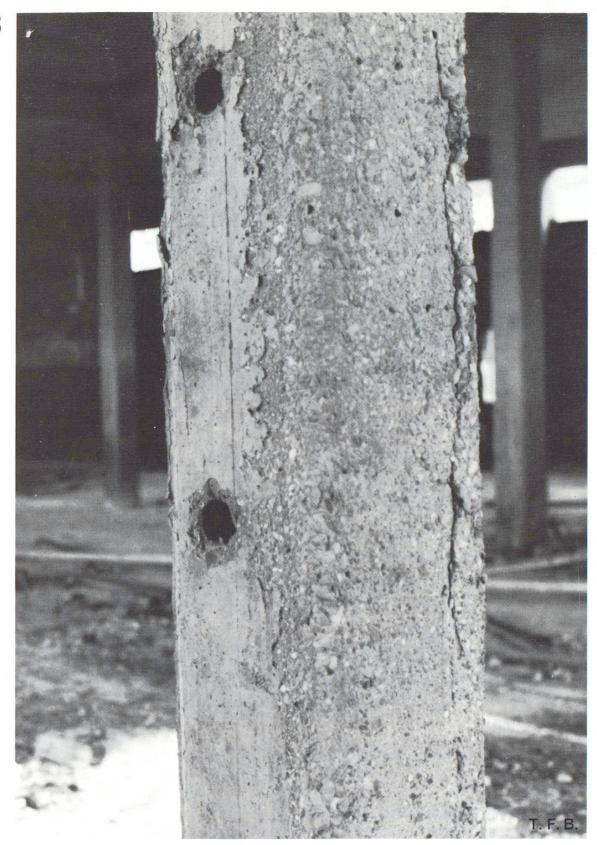
Abb. 2 Einfache schlanke Betonstütze blieb trotz starker einseitiger Hitzebelastung funktionstüchtig.
