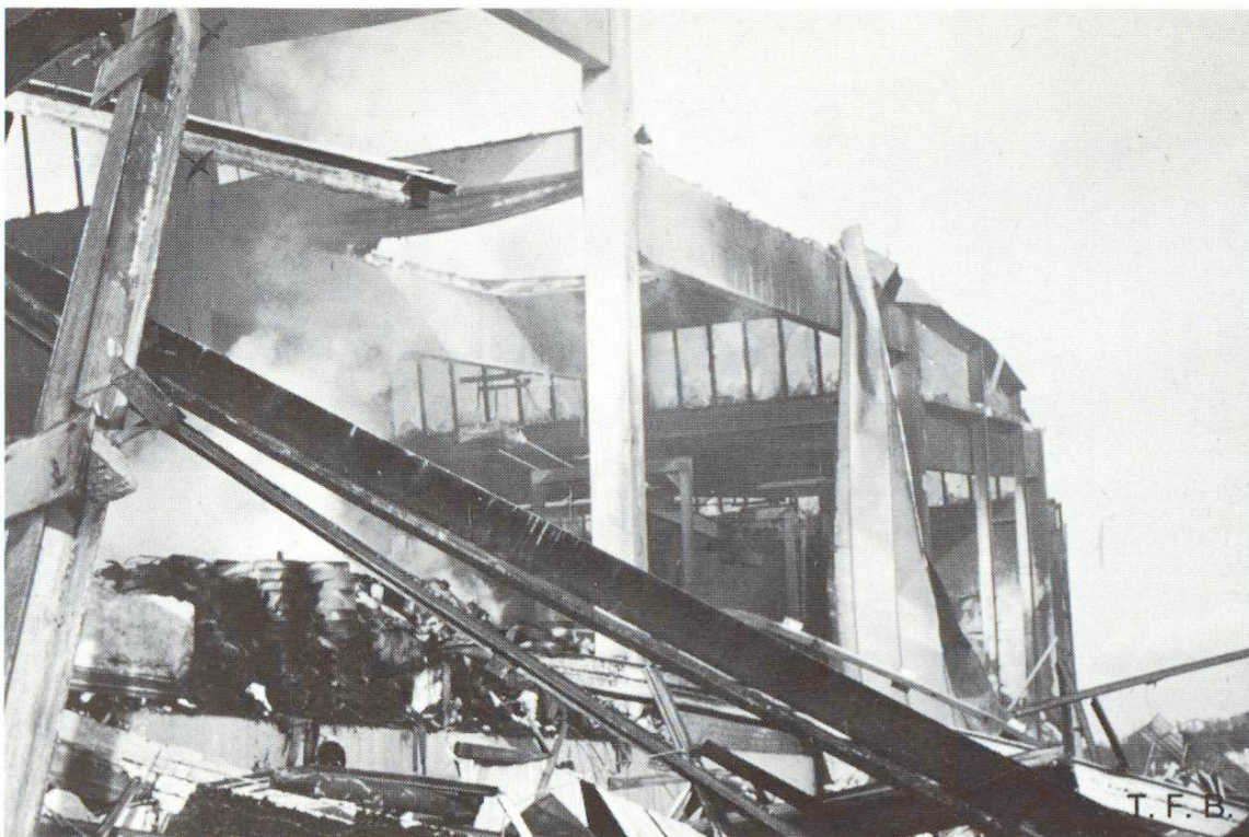
Abb. 5 Das unterschiedliche Verhalten von Metall- und Betonkonstruktionen bei starken Bränden ist auf diesem Bild erkennbar.
