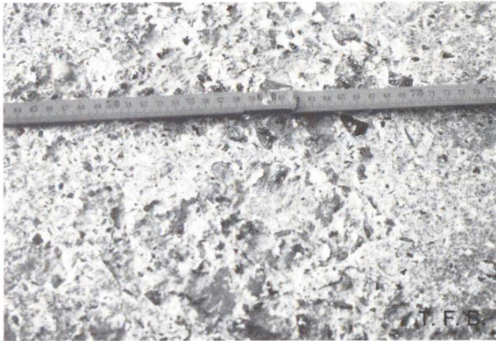
Abb. 2 Absplitterung durch Tausalzeinwirkung auf einer Treppenstufe.
