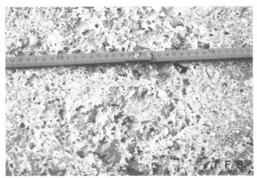
Abb. 2 Absplitterung durch Tausalzeinwirkung auf einer Treppenstufe.
