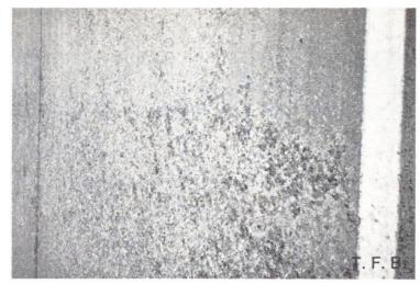
Abb. 1 Tausalzschäden auf einer Betonstrasse
