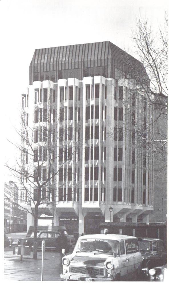
Abb. 2 Die senkrechten Stäbe mit ihrer Einspannung oben und unten werden mit den Saiten einer Harfe verglichen.
