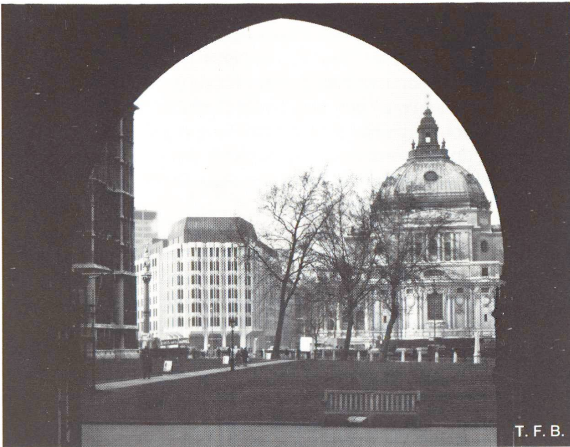
Abb. 3 Blick auf Abbey House und Westminster Central Hall vom Eingang der St. Margret's Chapel.
