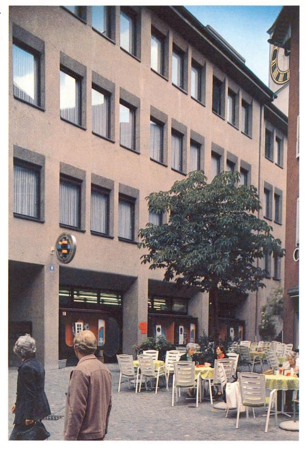
Abb. 4 Kantinengebäude Schweizerischer Bankverein, Zürich Architekt: Georg Künzler, Dietikon Ortbeton eingefärbt und gestockt.
