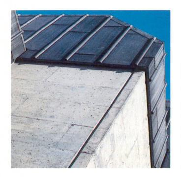
Konstruktiv besteht das Gebäude aus drei Hauptteilen: die massiven Bereiche aus unbehandeltem Stahlbeton, welche eine Art Gebäudesockel bilden; das Traggerippe in Stahl, bestehend aus geschweissten Strebenfachwerkträgern, die teilweise auf dem massiven Gebäudesockel, teilweise auf Stahlstützen aufliegen; die mehrschichtige Aussenhaut in Leichtbauweise mit einer äusseren Verkleidung aus gefälzten Bleiplatten.
