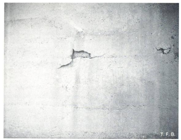
Abb. 3 Die Haftung von relativ dünnen Mörtelaufträgen ist oft in Frage gestellt. In diesem Fall wurden offenliegende Bewehrungseisen abgedeckt, doch schon nach einem Jahr löste sich der Flickmörtel wieder ab.
