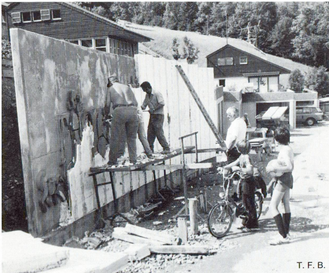
Abb. 7 Das Relief kommt zum Vorschein. Der Guss ist offensichtlich gelungen.
