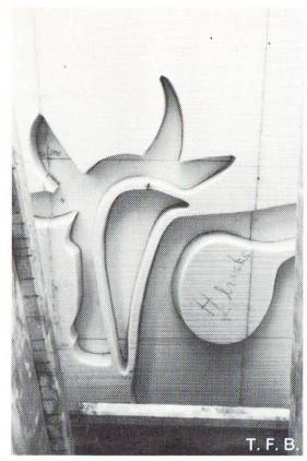
Abb. 1 Aufbau des formgebenden Schalungskörpers aus Grundplatte und zwei 50-mm-Schichten aus zugeschnittenem Schaumstoff.
