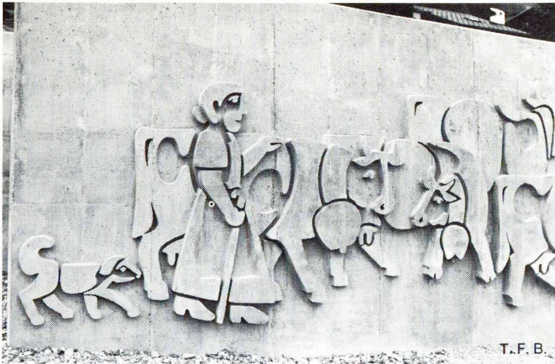
Abb. 9 Dieses Bild vom Schluss des Alpaufzuges zeigt charakteristische Merkmale des Betons, die in ungezwungener Weise einbezogen sind. Man erkennt auch, mit welcher Sorgfalt und Genauigkeit die einzelnen Formteile zugeschnitten und aufgesetzt werden mussten.
