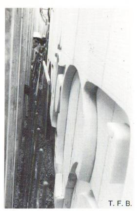
Abb. 2 Blick in die Schalung. An der Rückseite sind erst die untersten Schalungsbretter eingesetzt.
