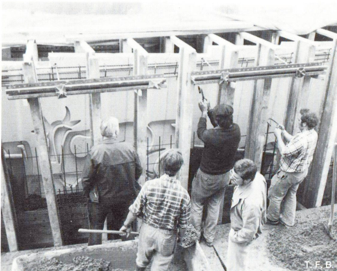
Abb. 3 Zur Schonung der empfindlichen Schalungsteile setzte man Schutztafeln ein, welche erst beim Verdichten des Betons langsam hochgezogen wurden. Auch die Armierung wurde stufenweise eingebaut.
