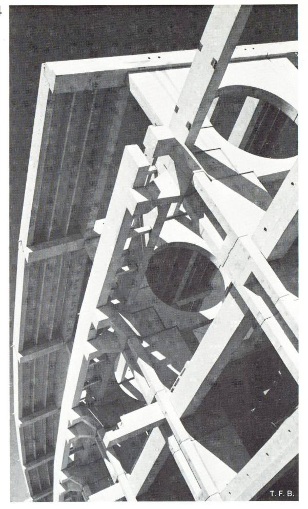
Abb. 4 Tragrahmen für das Mittelschiff mit den ringförmigen Aussteifungsscheiben. Der Tragbalken für die Überdachung des Seitenschiffes liegt auf auskragenden gabelförmigen Konsolen. Damit wird eine gute architektonische Wirkung erzielt.
