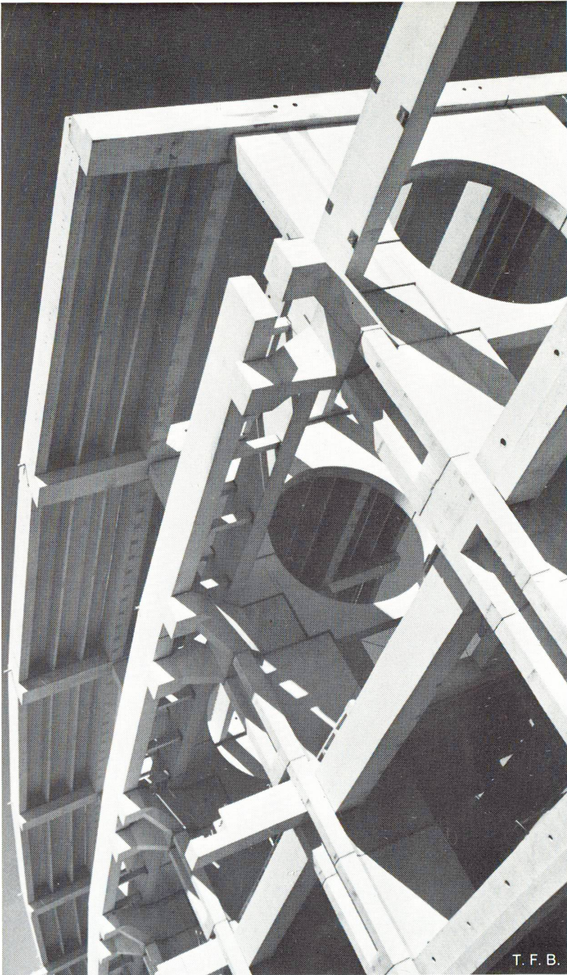
Abb. 4 Tragrahmen für das Mittelschiff mit den ringförmigen Aussteifungsscheiben. Der Tragbalken für die Überdachung des Seitenschiffes liegt auf auskragenden gabelförmigen Konsolen. Damit wird eine gute architektonische Wirkung erzielt.
