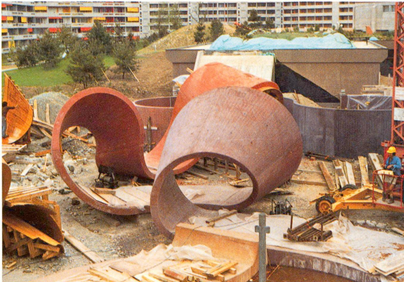
und dass vom Schalungsbauer und Betonarbeiter Ausserordentliches an praktischer Überlegungskunst und Geschick gefordert wurde. Die Zusammensetzung des Betons bezüglich Zement- und Farbstoffzugabe wurde vom entwerfenden Künstler selber erprobt und bestimmt. Die Betonmischungen wurden in einem kleineren Zwangsmischer auf der Baustelle hergestellt. Wichtig dabei war die gründliche Durcharbeitung des frischen Betons, um Gleichmässigkeit und geschmeidige Konsistenz zu erreichen.
