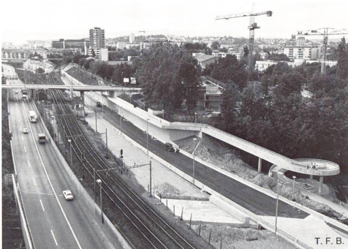
Abb. 1 Übersicht über die Verkehrsanlagen im Gellert-Dreieck, Basel. Autostrasse, Eisenbahn, Fussgängerweg.
