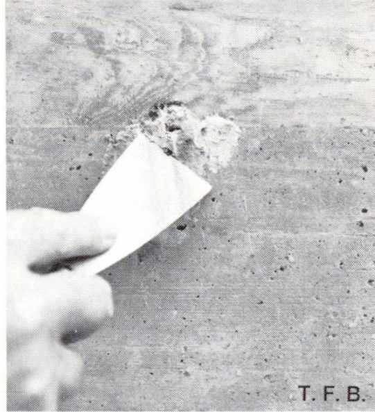
Abb. 6 Die eingetrocknete Adsorptionspaste wird entfernt.
