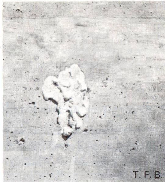
Abb.10 Adsorptionspaste eingetrocknet.
