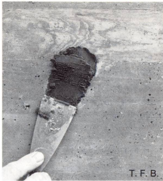
Abb. 4 Die Adsorptionspaste wird dem Flecken angelegt und angepresst.
