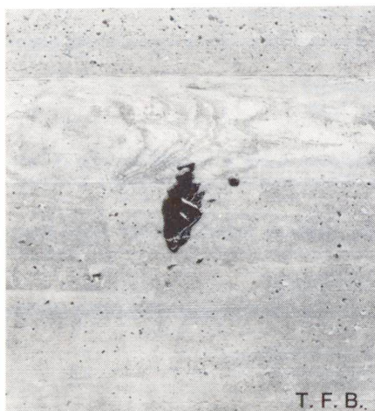
Abb. 1 Sichtbetonfläche verunreinigt durch heisses Bitumen.
