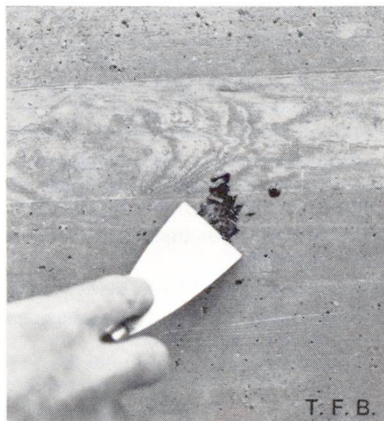
Abb. 2 Mit dem Spachtel wird soviel wie möglich des verunreinigenden Fremdmaterials entfernt.
