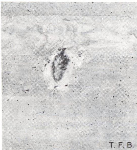
Abb. 7 Die bituminöse Verunreinigung ist noch nicht restlos entfernt.
