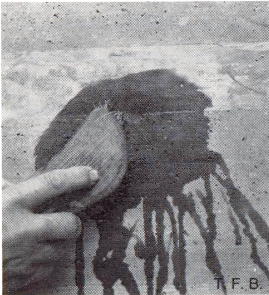
Abb.11 Adsorptionspaste wird entfernt, am Schluss mit Bürste und Seifenwasser.
