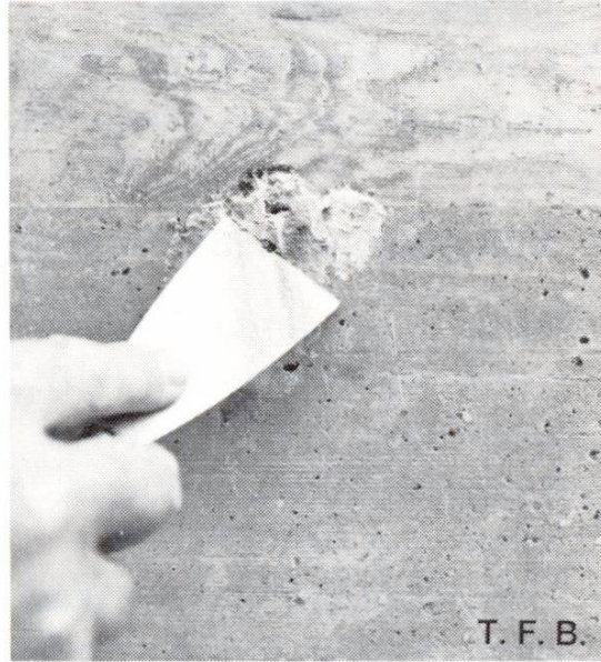
Abb. 6 Die eingetrocknete Adsorptionspaste wird entfernt.
