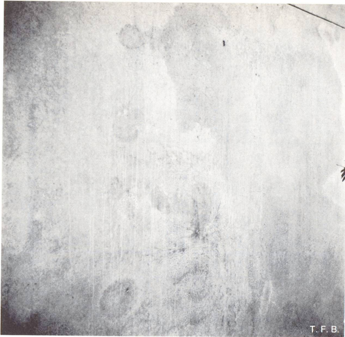
Abb. 2 Durch Beton ausgewalztes, pastenförmiges Entschalungsmittel vom Typ C zeichnet sich auf der Betonoberfläche ab.
