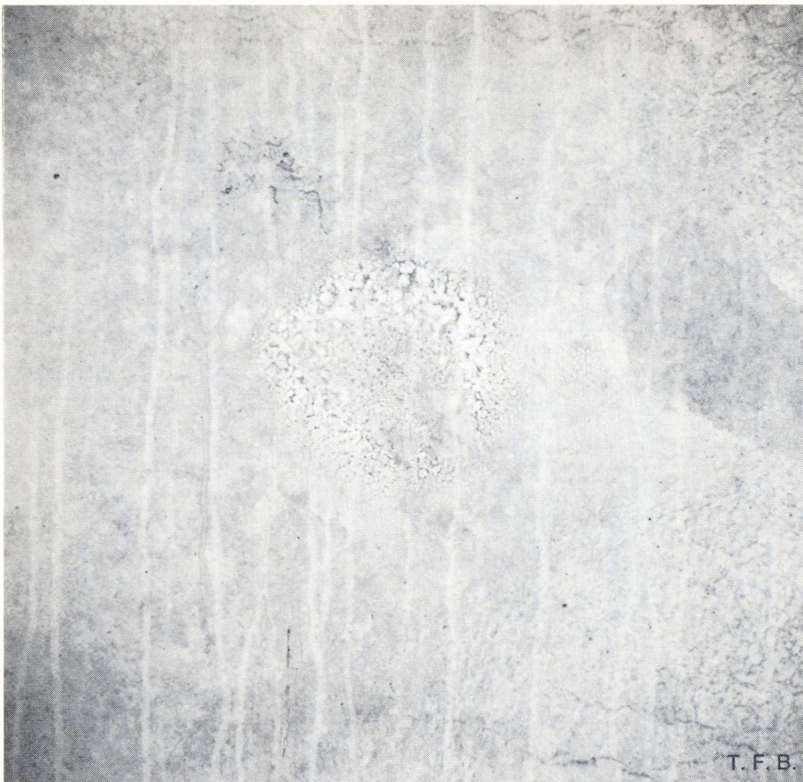
Abb. 3 Zwischen Beton und liegender Schalung eingeschlossenes flüssiges Schalungöl wird durch die Vibration in kleine Einzeltropfen aufgeteilt, die sich in der Betonoberfläche abzeichnen
