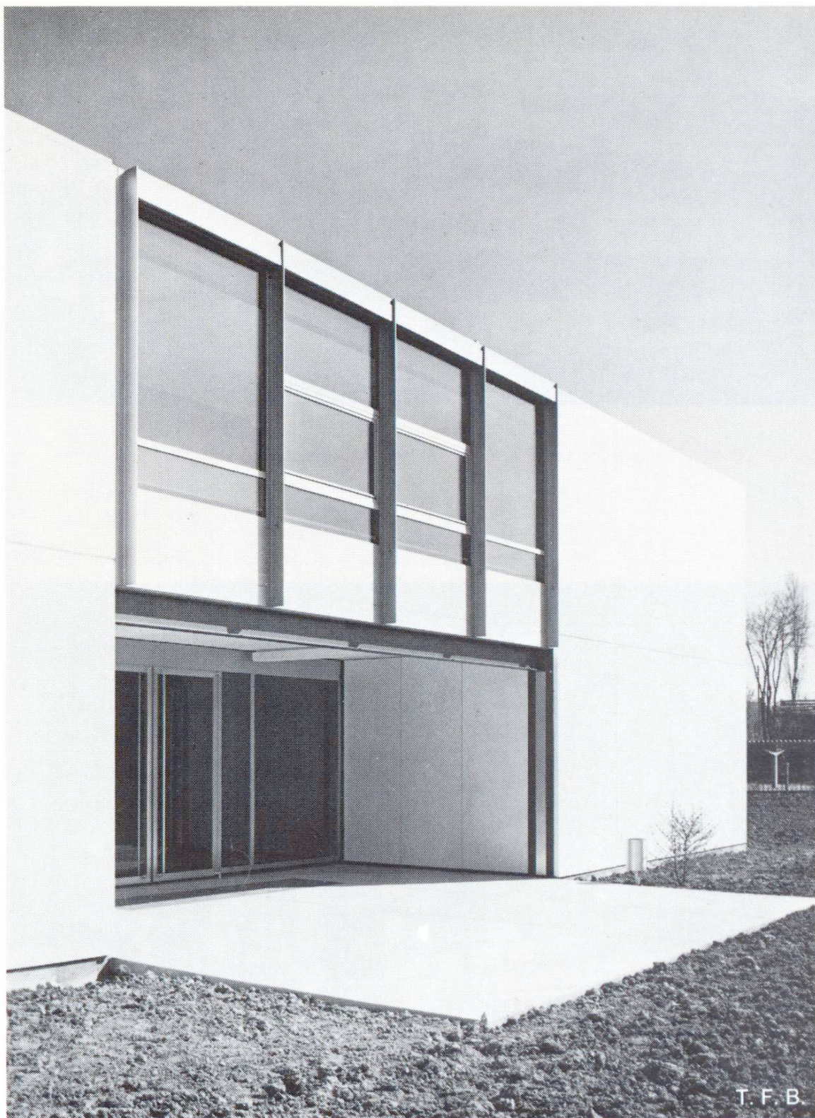
Abb. 5 Schulhaus in Hubersdorf. Glatte Betonschalung, gestrichen.
