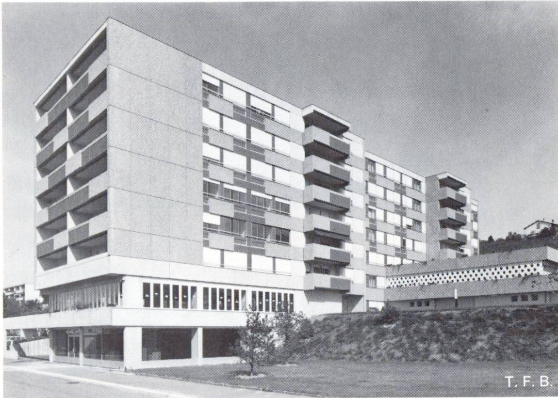
Abb. 7 Wohnbau in Lutry. Waschbeton mit dunklem Zuschlagsstoff, kombiniert mit Platten aus Holzschalung.
