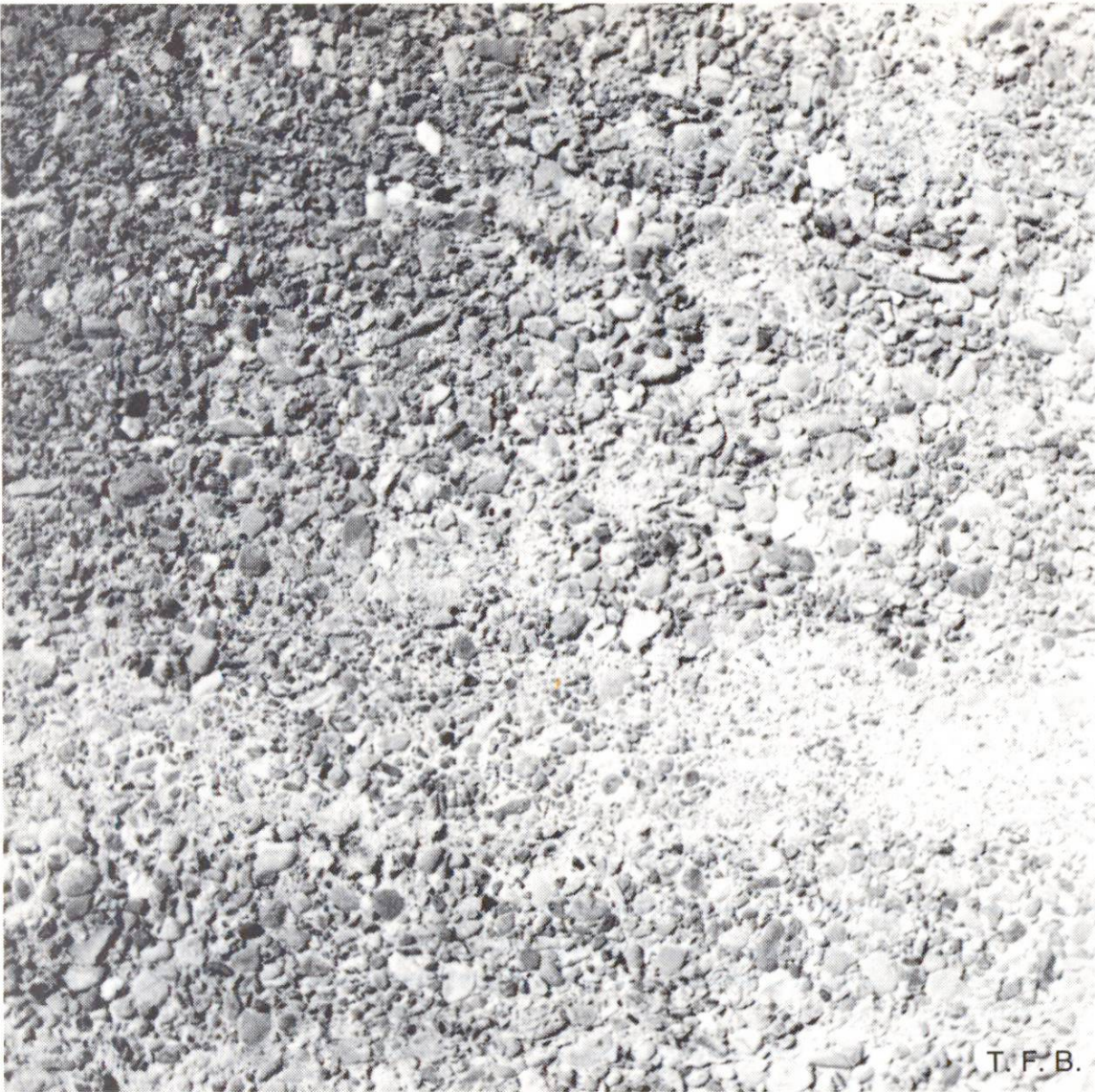
Abb.1 Dieser Waschbeton zeigt eine mögliche Entmischung zwischen verschiedenen Grössen des Grobzuschlages. Die Betonmischung hat zu wenig und zu flüssige Mörtelsubstanz erhalten.
