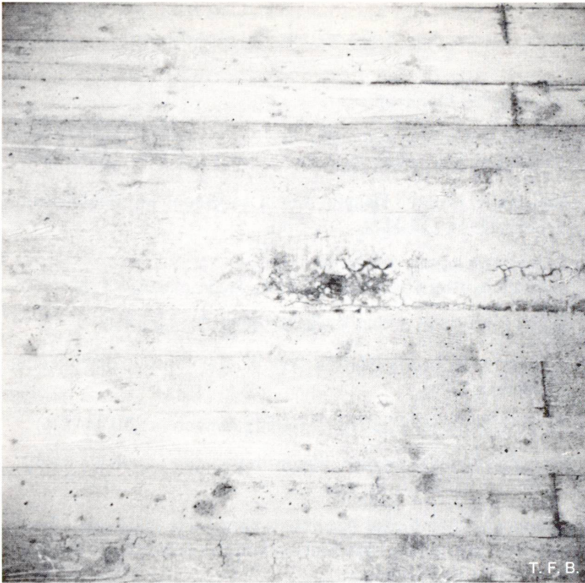
Abb. 3 Halbwegs geschlossenes Kiesnest bei Beton mit zu geringem Anteil an Mörtelsubstanz.
