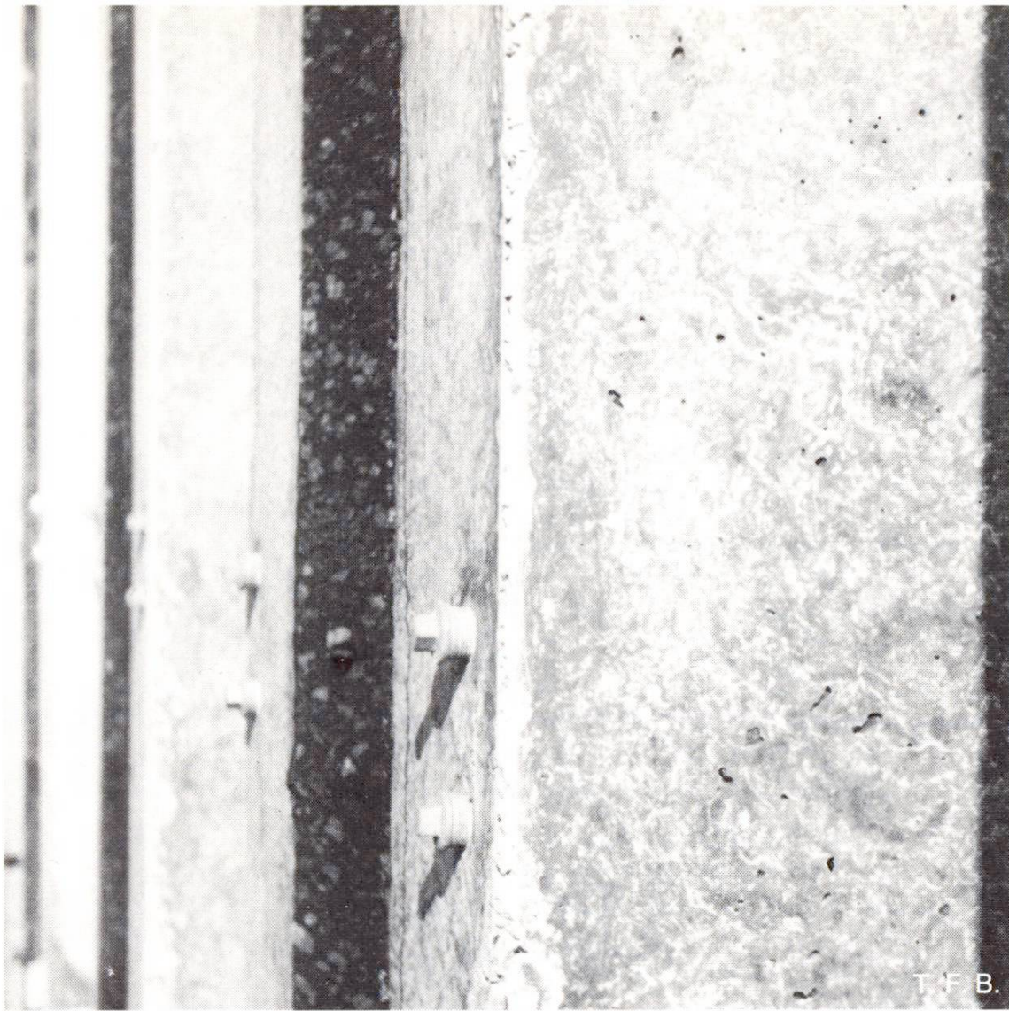
Abb. 2 Entmischung der feinsten Kornanteile bei unstabilem Feinmörtel, ausgelöst durch intensive Vibration.
