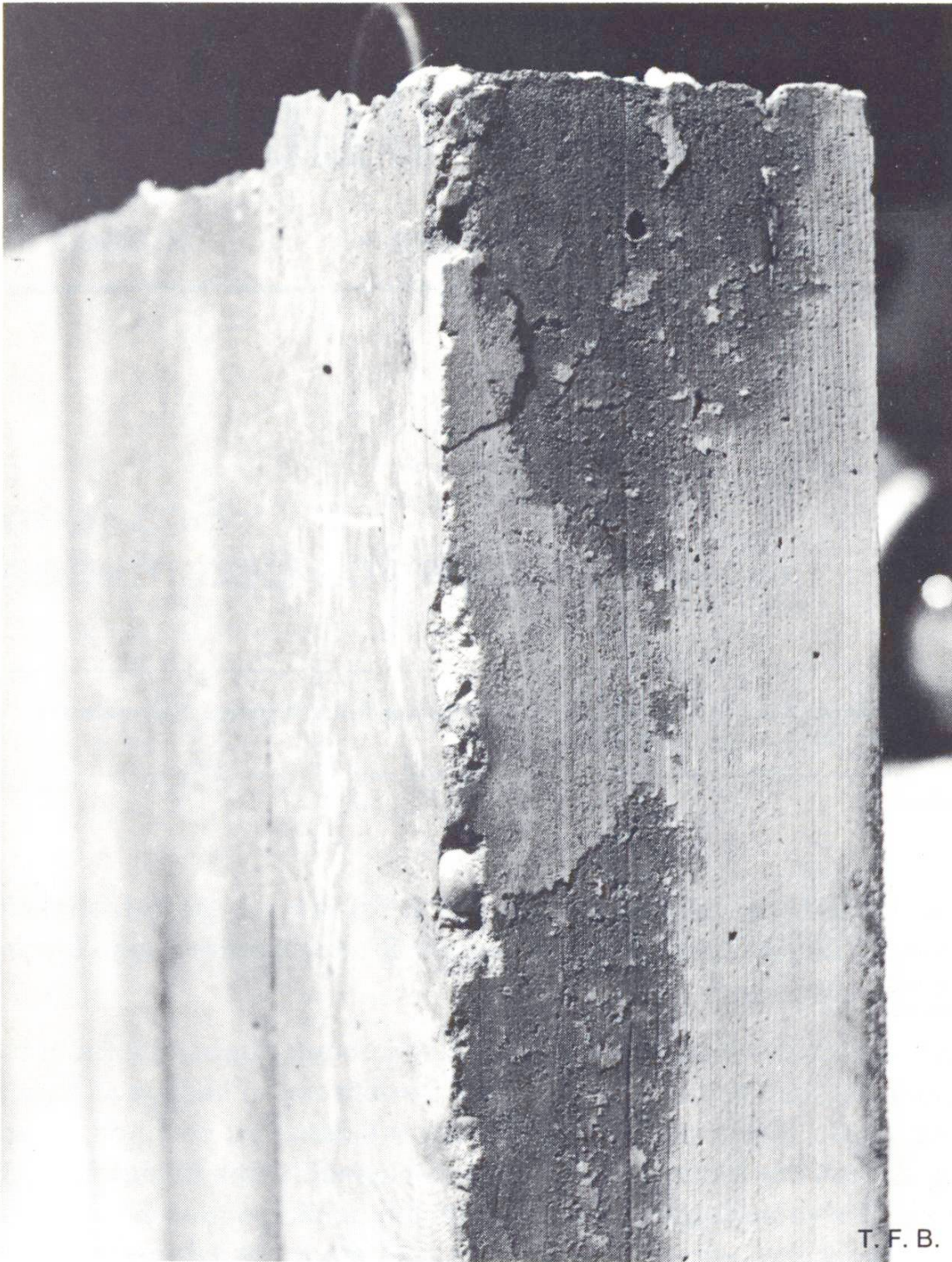
Abb. 1 Durch Quellen der Holzschalung abgedrückte Kanten.
