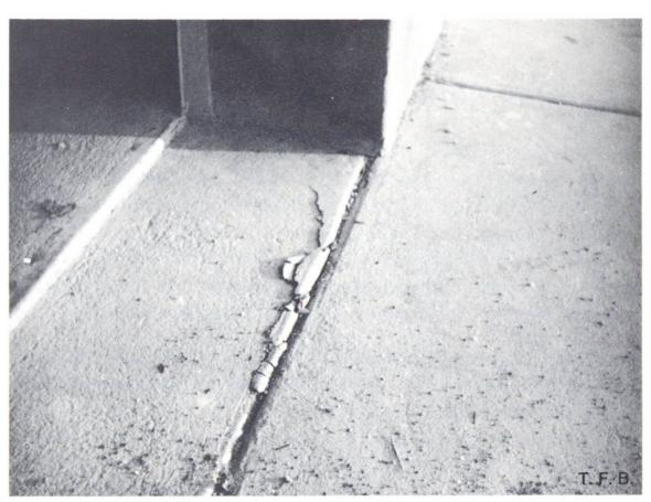
Abb. 4 Durch das Reiben der Kante, evtl. unter Besprengung mit zusätzlichem Wasser, ist der Beton stark geschwächt und Frostschäden vermehrt ausgesetzt.
