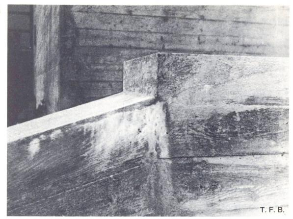
Abb. 3 Stark bearbeitete Mauerkrone mit Schwindrissbildung.
