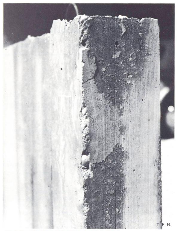
Abb. 1 Durch Quellen der Holzschalung abgedrückte Kanten.
