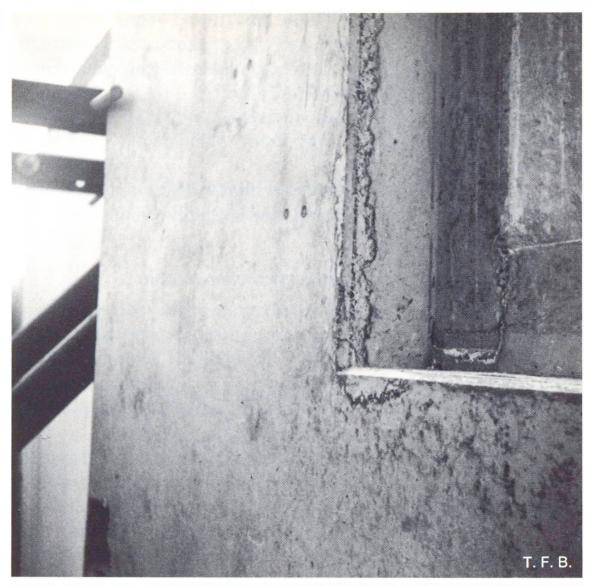
Abb. 2 Folgen der undichten Schalung bei der Kante. Durch ausfliessenden Zementmörtel ist der Beton in diesem Bereich geschwächt.
