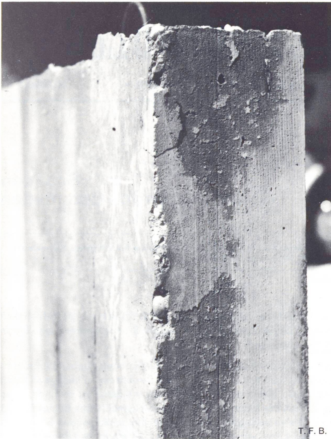
Abb. 1 Durch Quellen der Holzschalung abgedrückte Kanten.
