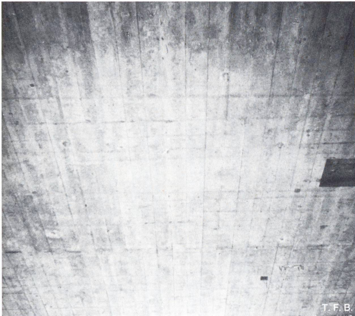
Abb.3 Strichförmige Rostflecken auf einer Betonuntersicht. Stark rostige Bewehrungsstäbe wurden auf die Schalungsfläche ausgelegt und übertrugen dabei den Roststaub.
