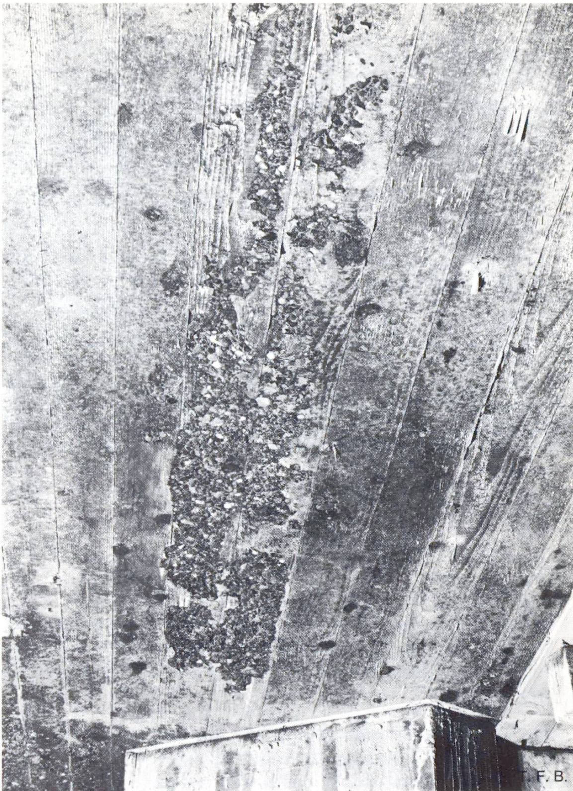
Abb. 5 Verdünnung des Betons durch Wasserpützen und nachfolgende zusätzliche Entmischung führten zu einer Schwächung des Betonmörtels im Bereich der Schalungsfläche. Die Folge davon war eine Trennung des Zementsteins vom Zuschlagsgestein.
