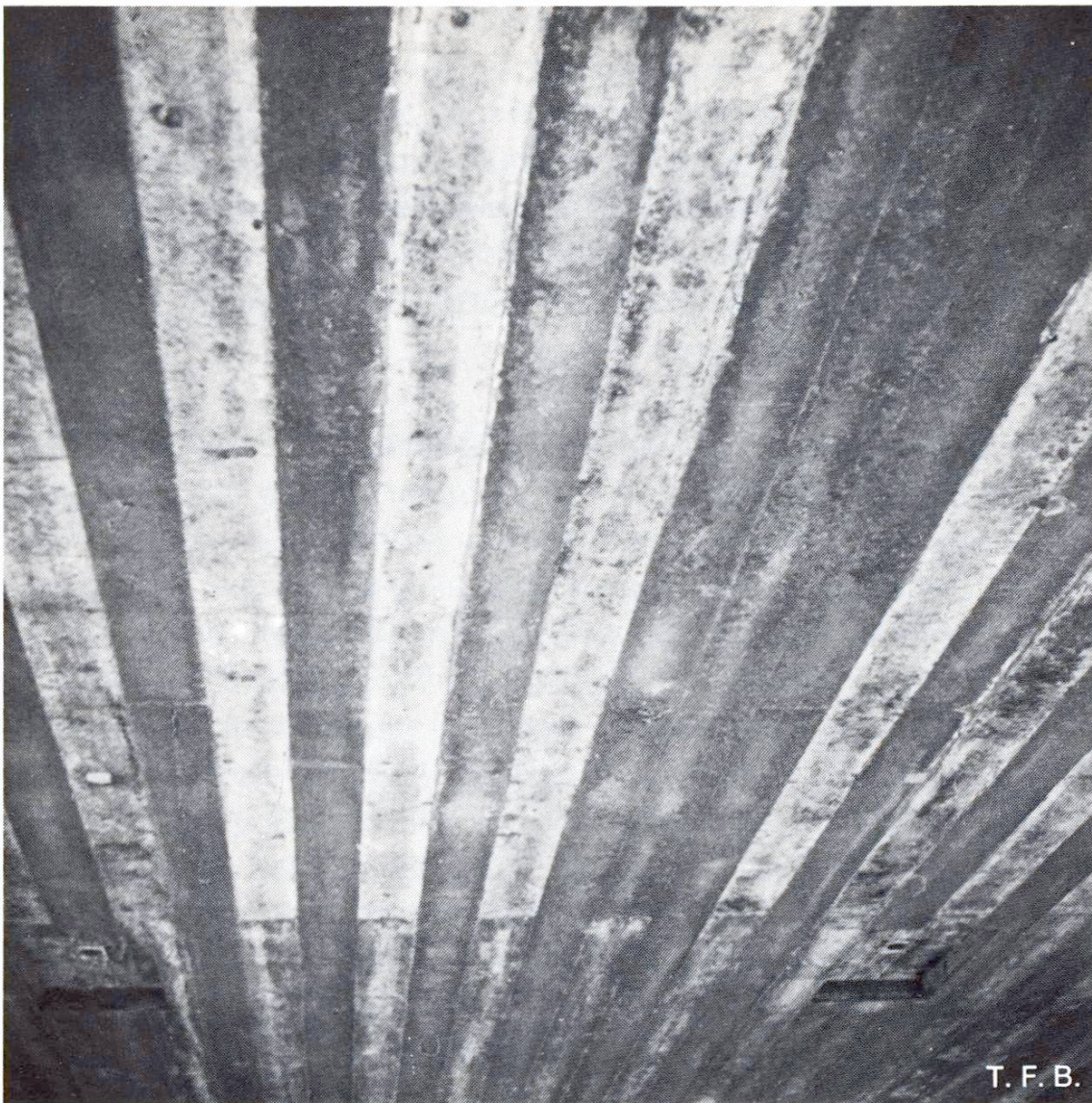
Abb. 6 Ungleichmässiges Schwinden einzelner Schalungsbretter führt zu starken Unregelmässigkeiten der Grautönung.
