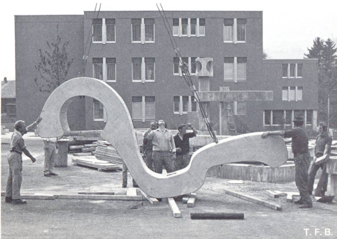
Abb. 5 Aufziehen des figürlichen Säulenaufsatzes zur Montage.
