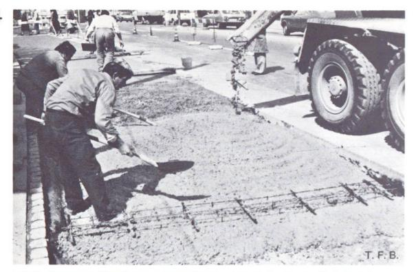
Abb. 3 Einsatz von Fliessbeton auf einer Kleinbaustelle. Belag für eine Bushaltestelle.
