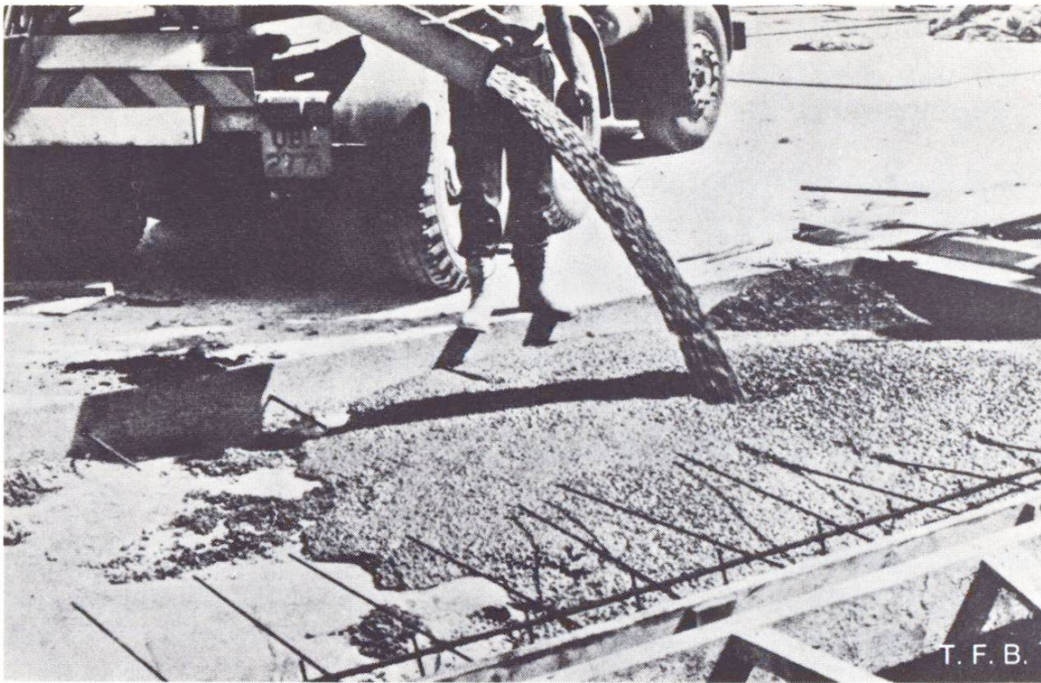
Abb. 2 Selbständige Ausbreitung des Fliessbetons ohne Entmischungserscheinungen (Bild aus CCA-Report, s. Literaturangabe).
