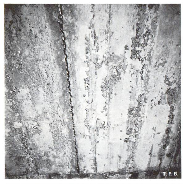
Abb. 5 Beton mit geringem Zementgehalt neigt zur Wasserausscheidung und damit zu Oberflächenschädigungen.
