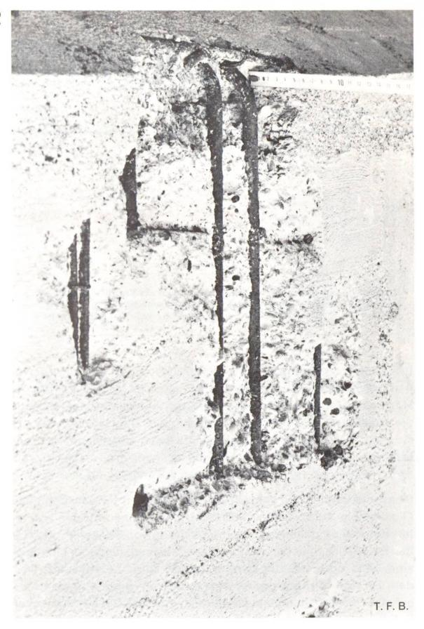
Abb. 1 Bei ungenügendem Zementgehalt und zu geringer Überdeckung erhöht sich die Gefahr der Bewehrungskorrosion. Der unterdosierte Beton enthält nicht nur weniger schützendes Calciumhydroxid, sondern dieses wird infolge der stärkeren Porosität auch rascher abgebaut.
