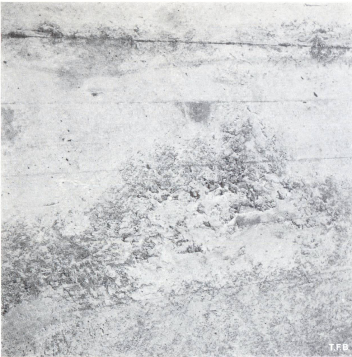
Abb. 4 Kiesnest, das unter der Rüttelverdichtung teilweise mit Betonmörtel zugefüllt wurde. Beim Fliessvorgang haben sich Korngerüstfilter mit Anreicherungen von Zementteilchen gebildet, ähnlich wie bei undichter Schalung Abb. 2 und 3.
