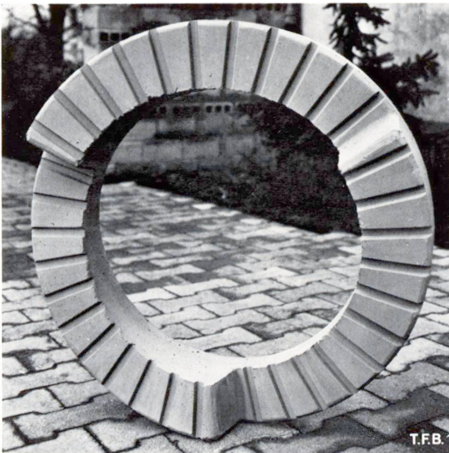
Abb. 3 Tragring als Gegenstück zur Muffe mit Einkerbungen zum Festhalten in der gewünschten Stellung.
