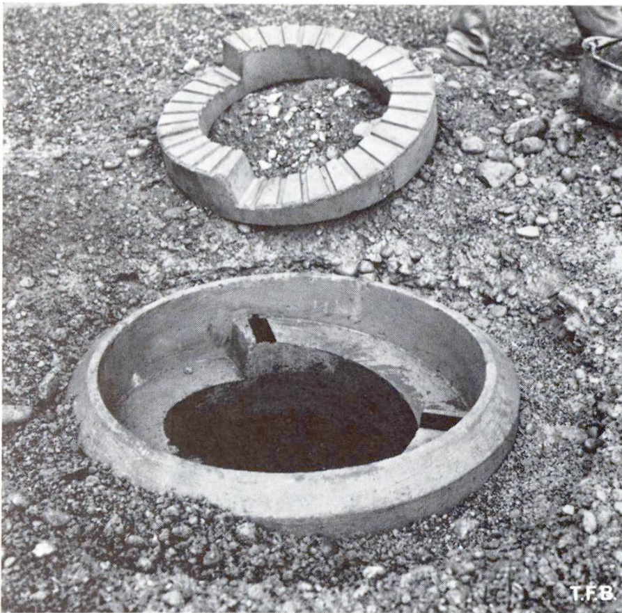
Abb. 6 Eingebaute Muffe bei Beginn der Planierungsarbeiten.
