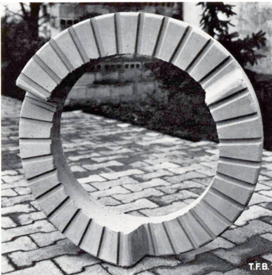
Abb. 3 Tragrings als Gegenstück zur Muffe mit Einkerbungen zum Festhalten in der gewünschten Stellung.
