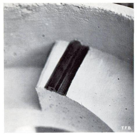
Abb. 4 Nocken aus Neopren zur Verankerung des Tragringes.
