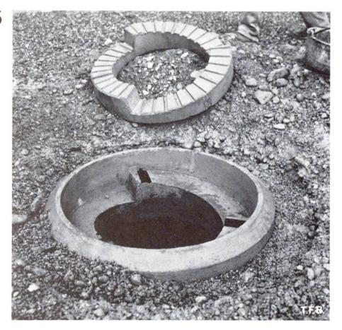
Abb. 6 Eingebaute Muffe bei Beginn der Planierungsarbeiten.
