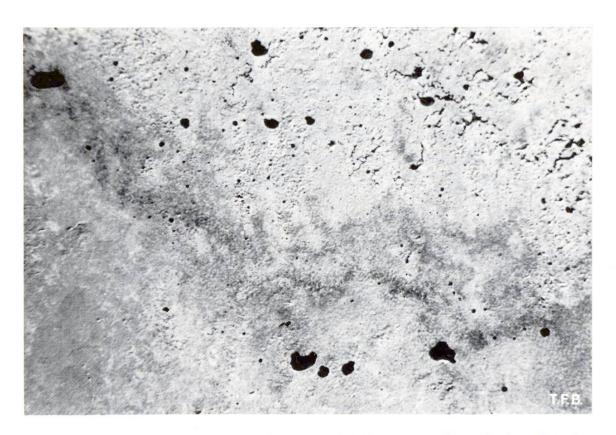
Abb. 6 Entmischungen (Wasserausscheidung) und Kiesnest im Bereich einer Betonierfuge. Solche Erscheinungen sind bei zu kurzen Mischzeiten häufiger anzutreffen.
