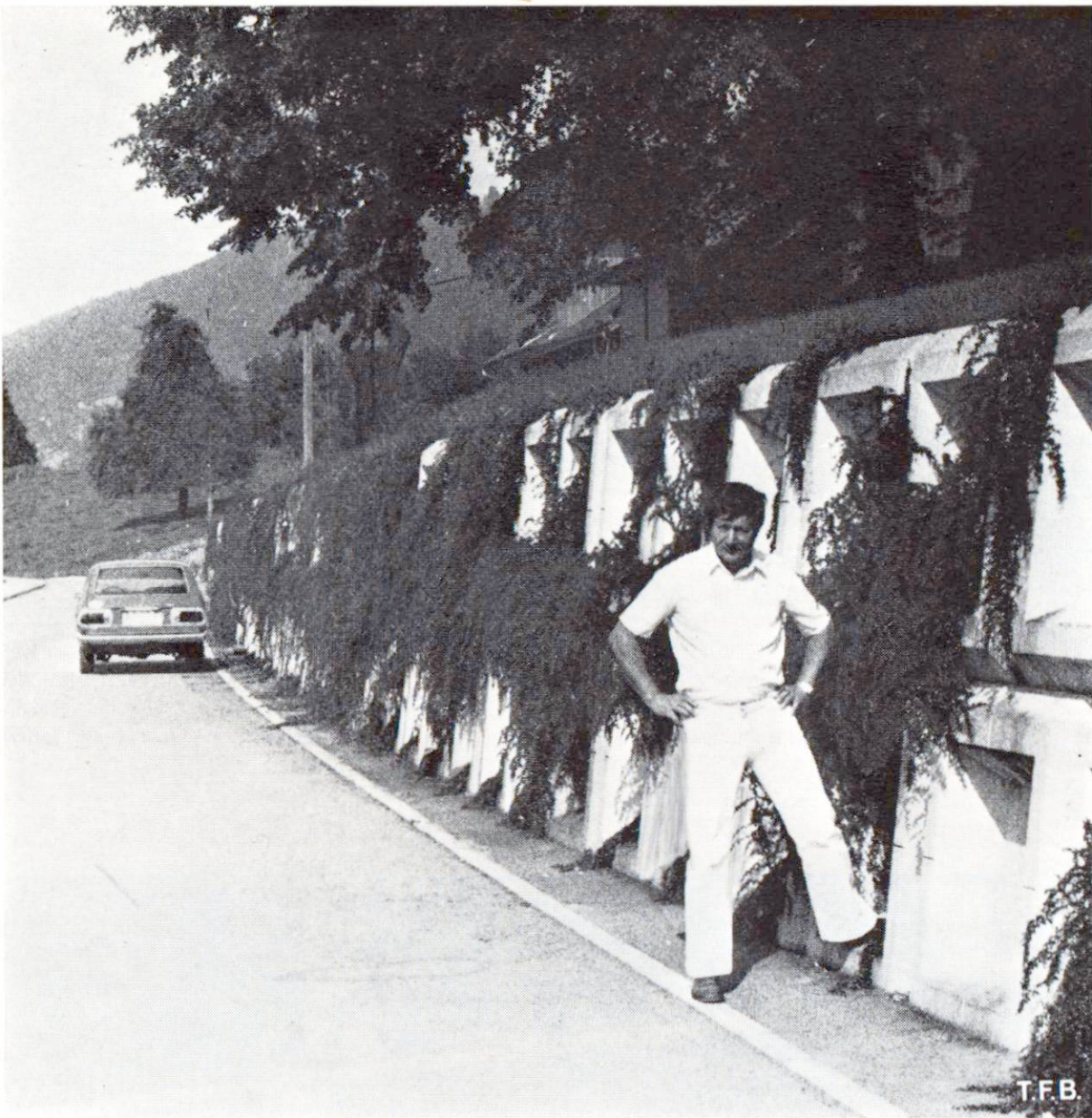
Abb. 12 Eine Stützmauer wie Abb. 11 mit Bepflanzung.
