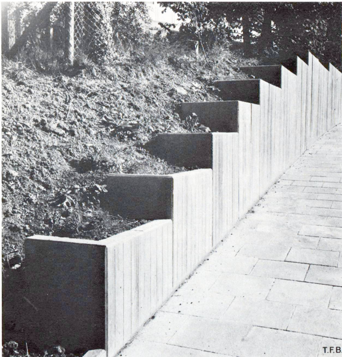
Abb. 5 Winkelelemente in einer ansteigenden Reihe versetzt ergeben natürliche Tröge für die Bepflanzung. Oberfläche mit klassischem Sichtbetonmuster ausgebildet.
