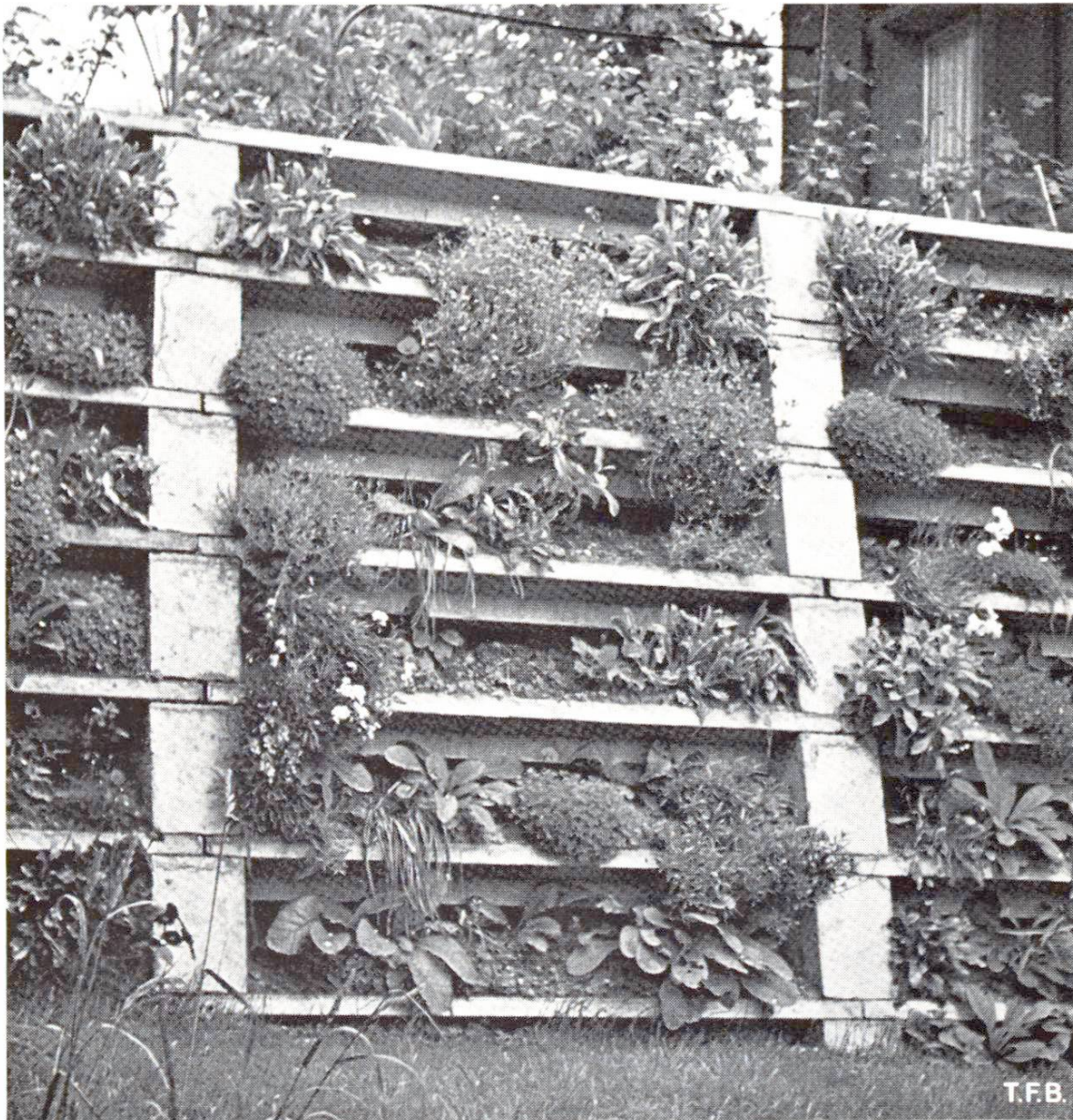
Abb. 3 Die in Abb. 1 und 2 im Aufbau gezeigte Stützkonstruktion mit Bepflanzung.
