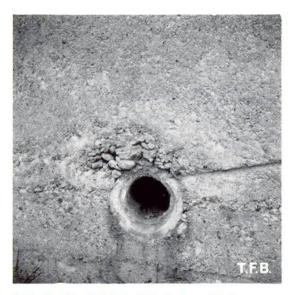
Abb. 3 Undichtigkeit bei einer Einlage
