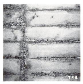
Abb. 1 Undichte Schalungsfugen
