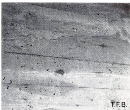
Abb. 6 Unter Druck nachgebende Schalung
