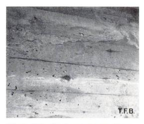
Abb. 6 Unter Druck nachgebende Schalung
