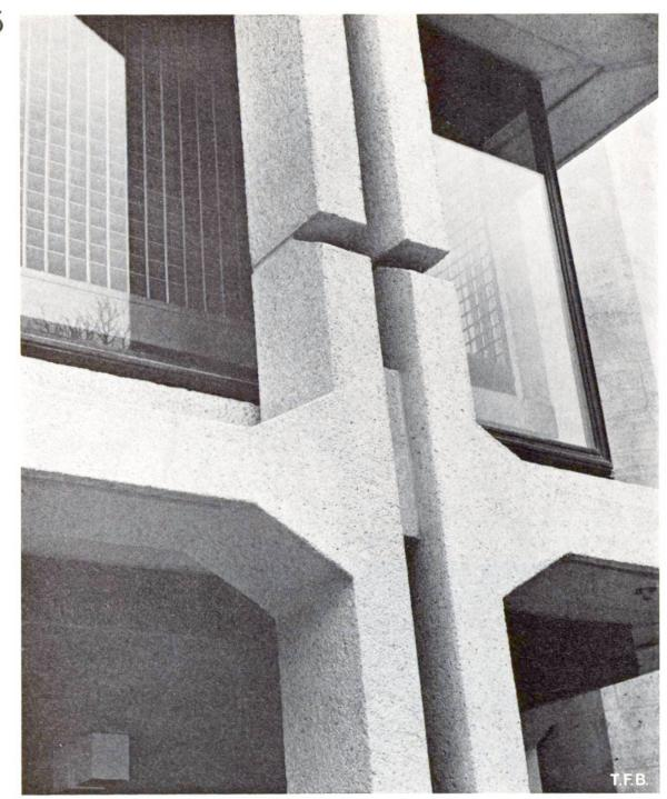
Abb. 5 Detail der vorfabrizierten gestockten Aussenstützen. Die Fassaden der Gebäude enthalten ein gesamthaft wirkendes System der Wasserableitung. Dadurch werden die Bildung von Rinnspuren und ungleichmässige Verschmutzungen der Gebäudeteile verhindert.
