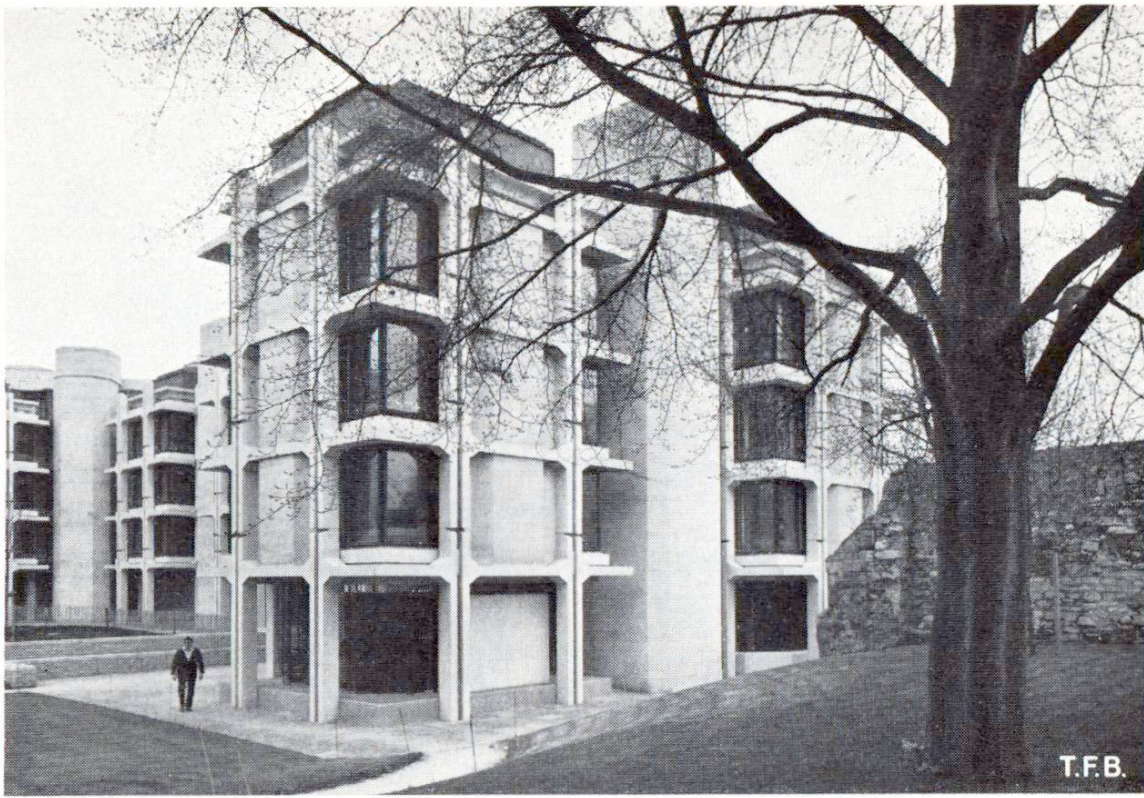
Abb. 2 Alte Gemäuer stehen in unmittelbarer Nachbarschaft zum neuen Bau. Die geschlossenen Treppenhaus-Türme sind mit glatten Betonplatten verkleidet.
