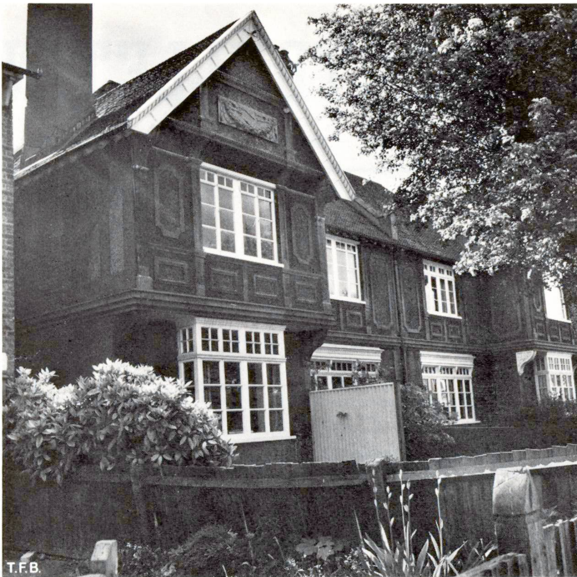
Abb. 1 Doppelhaus in Croydon, Süd-London, erstellt 1882 nach dem System Lascelles. Das Gebäude hat eine ansprechende Architektur und ist dunkelbraun gefärbt. Die Oberflächenzeichnungen der Beton-Fassadenplatten wurden mit der Schalung eingepreßt. Aus vorfabrizierten Betonteilen bestehen auch die Brüstungen, Gesimse, Träger und Zierplatten.
