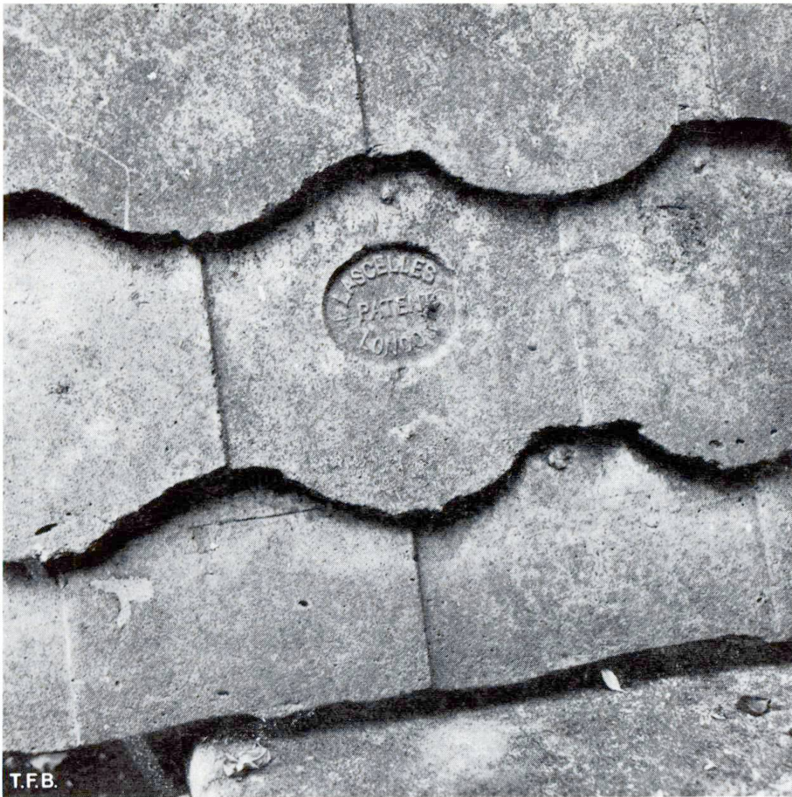
Abb. 3 Betonplatte mit Dachziegelmusterung und eingepägtem Patentsiegel.
