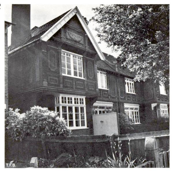
Abb. 1 Doppelhaus in Croydon, Süd-London, erstellt 1882 nach dem System Lascelles. Das Gebäude hat eine ansprechende Architektur und ist dunkelbraun gefärbt. Die Oberflächenzeichnungen der Beton-Fassadenplatten wurden mit der Schalung eingeprägt. Aus vorfabrizierten Betonteilen bestehen auch die Brüstungen, Gesimse, Träger und Zierplatten.
