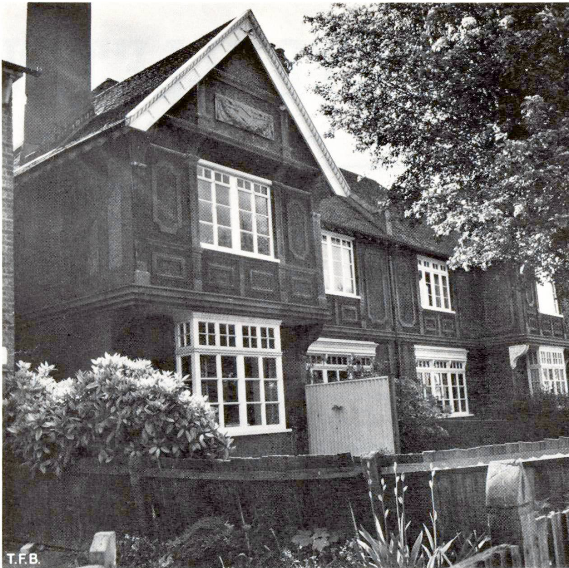
Abb. 1 Doppelhaus in Croydon, Süd-London, erstellt 1882 nach dem System Lascelles. Das Gebäude hat eine ansprechende Architektur und ist dunkelbraun gefärbt. Die Oberflächenzeichnungen der Beton-Fassadenplatten wurden mit der Schalung eingepägt. Aus vorgefertigten Betonteilen bestehen auch die Brüstungen, Gesimse, Träger und Zierplatten.
