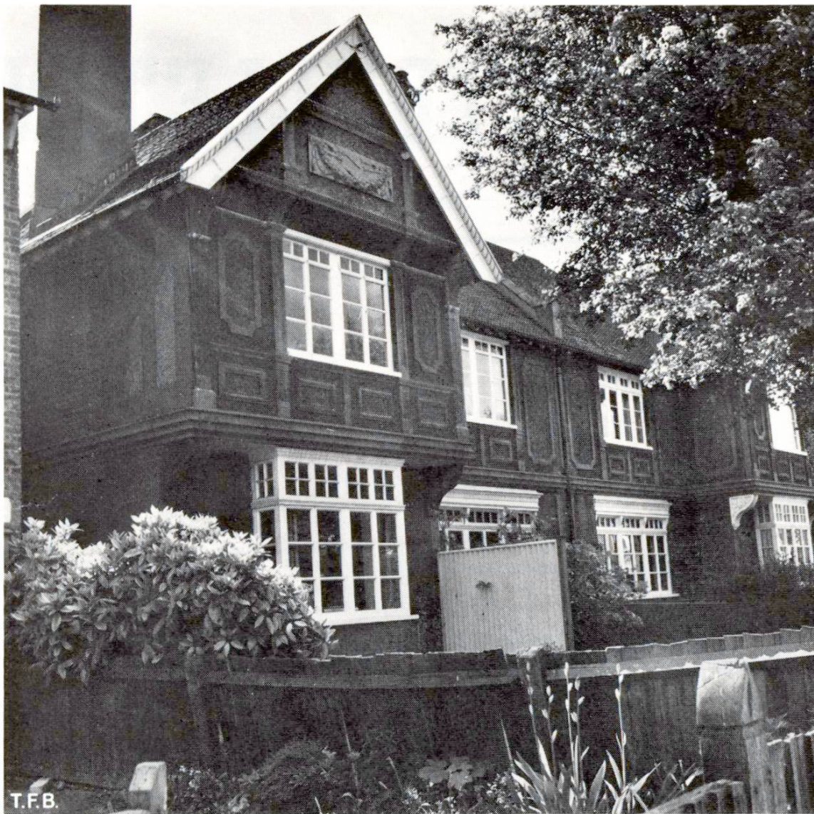
Abb. 1 Doppelhaus in Croydon, Süd-London, erstellt 1882 nach dem System Lascelles. Das Gebäude hat eine ansprechende Architektur und ist dunkelbraun gefärbt. Die Oberflächenzeichnungen der Beton-Fassadenplatten wurden mit der Schalung eingeprägt. Aus vorgefertigten Betonteilen bestehen auch die Brüstungen, Gesimse, Träger und Zierplatten.
