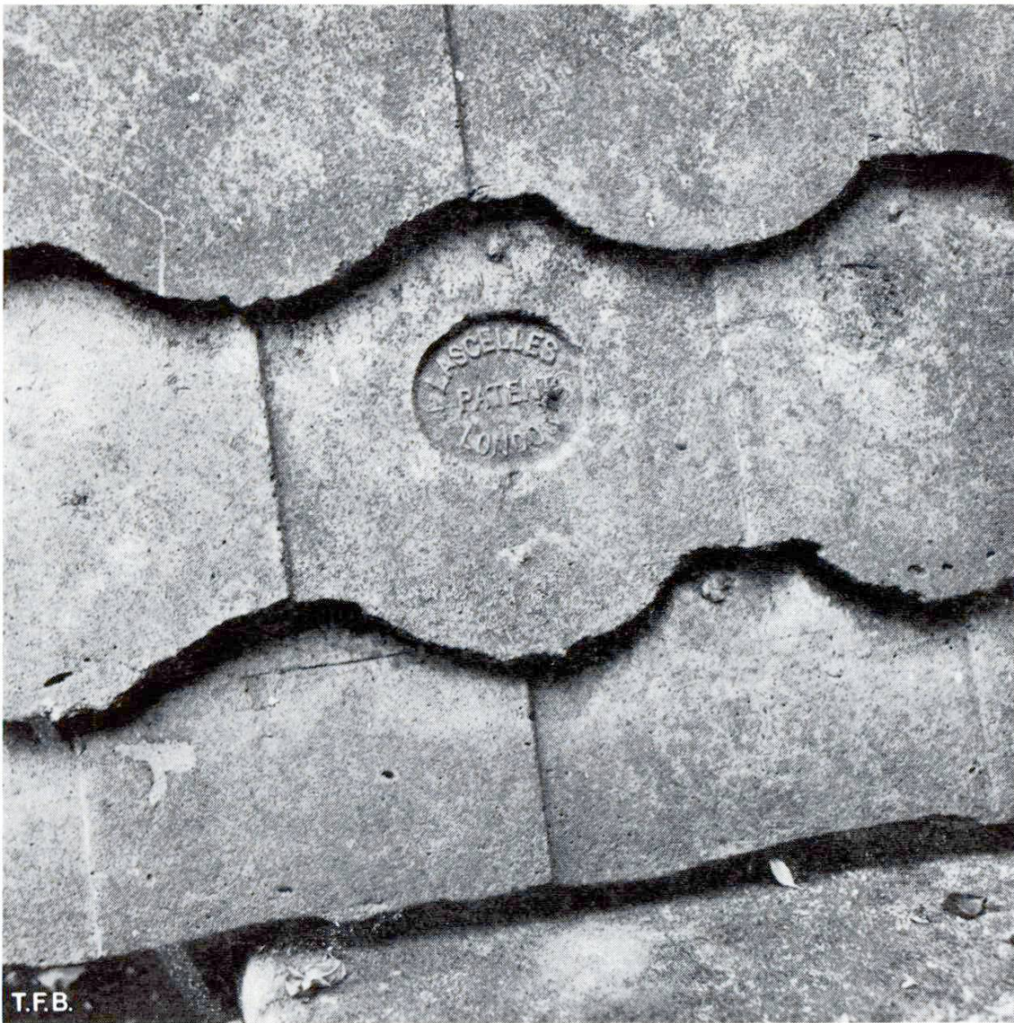
Abb. 3 Betonplatte mit Dachziegelmusterung und eingepägtem Patentsiegel.
