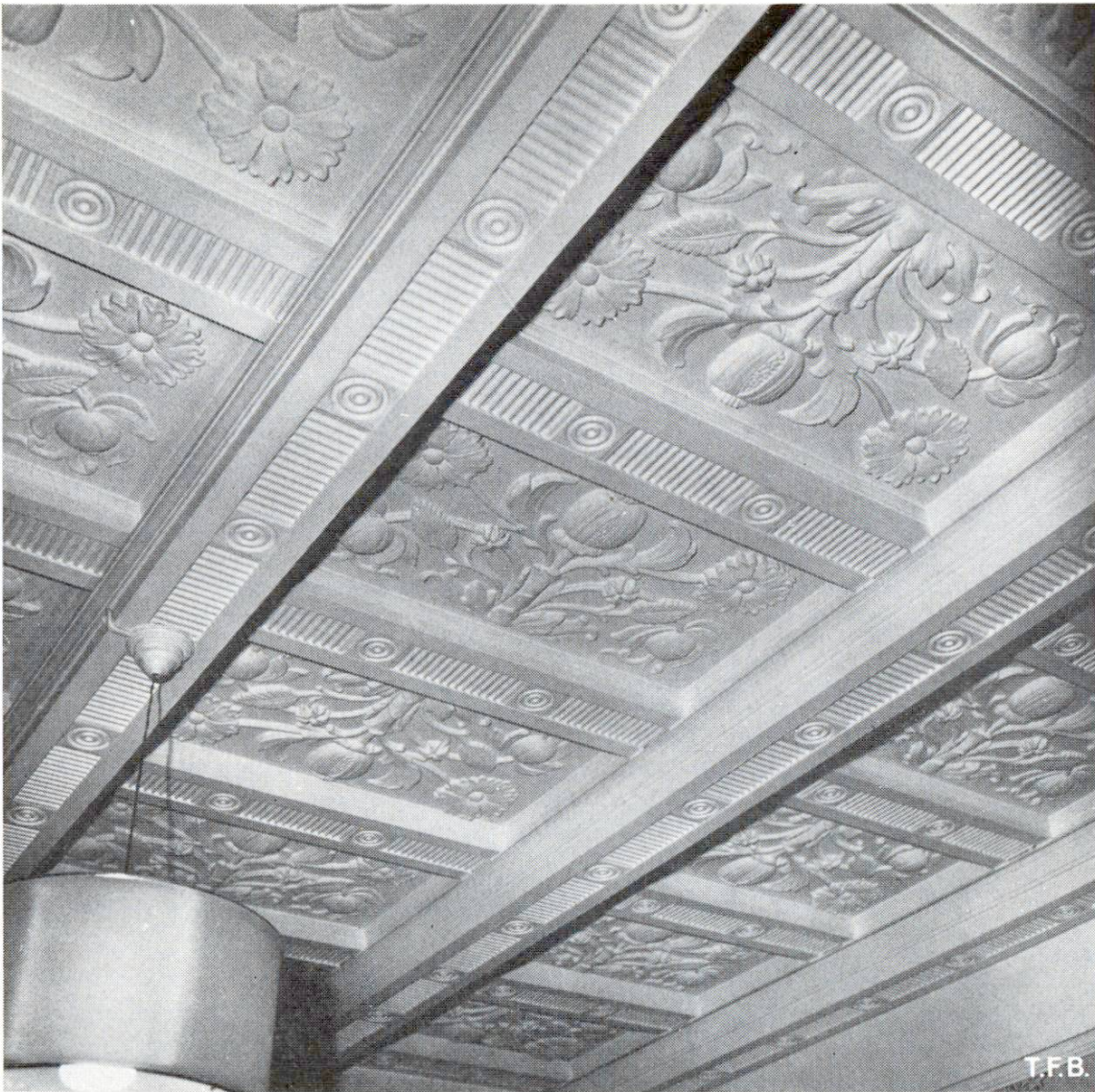
Abb. 2 Zimmerdecke aus vorfabrizierten Betonplatten mit Blumenornament eingelegt zwischen Holzbalken.
