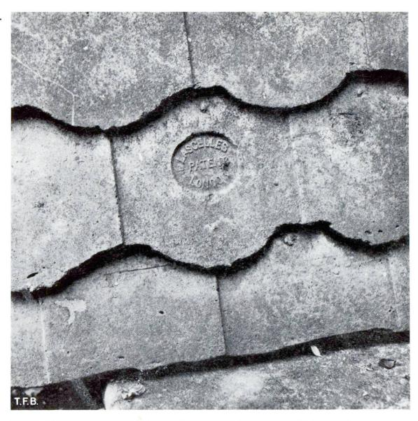
Abb. 3 Betonplatte mit Dachziegelmusterung und eingeprägtem Patentsiegel.
