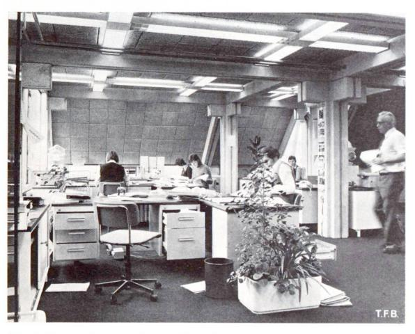
Abb. 4 Blick in einen der sehr wohnlichen Arbeitsräume. Ausfachung der Decken und schräggestellten Seitenwände mit Leichtbetonplatten.
