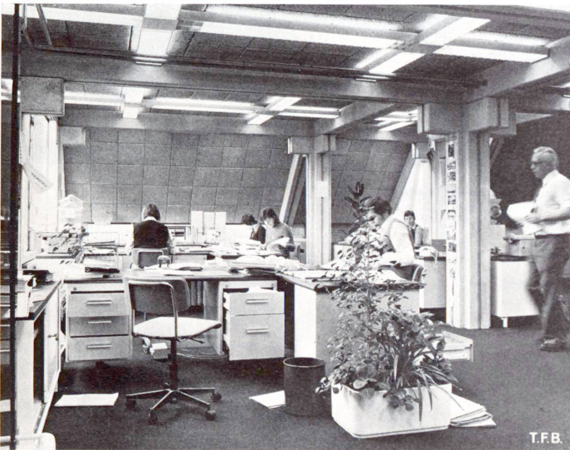
Abb. 4 Blick in einen der sehr wohnlichen Arbeitsräume. Ausfugung der Decken und schräggestellten Seitenwände mit Leichtbetonplatten.
