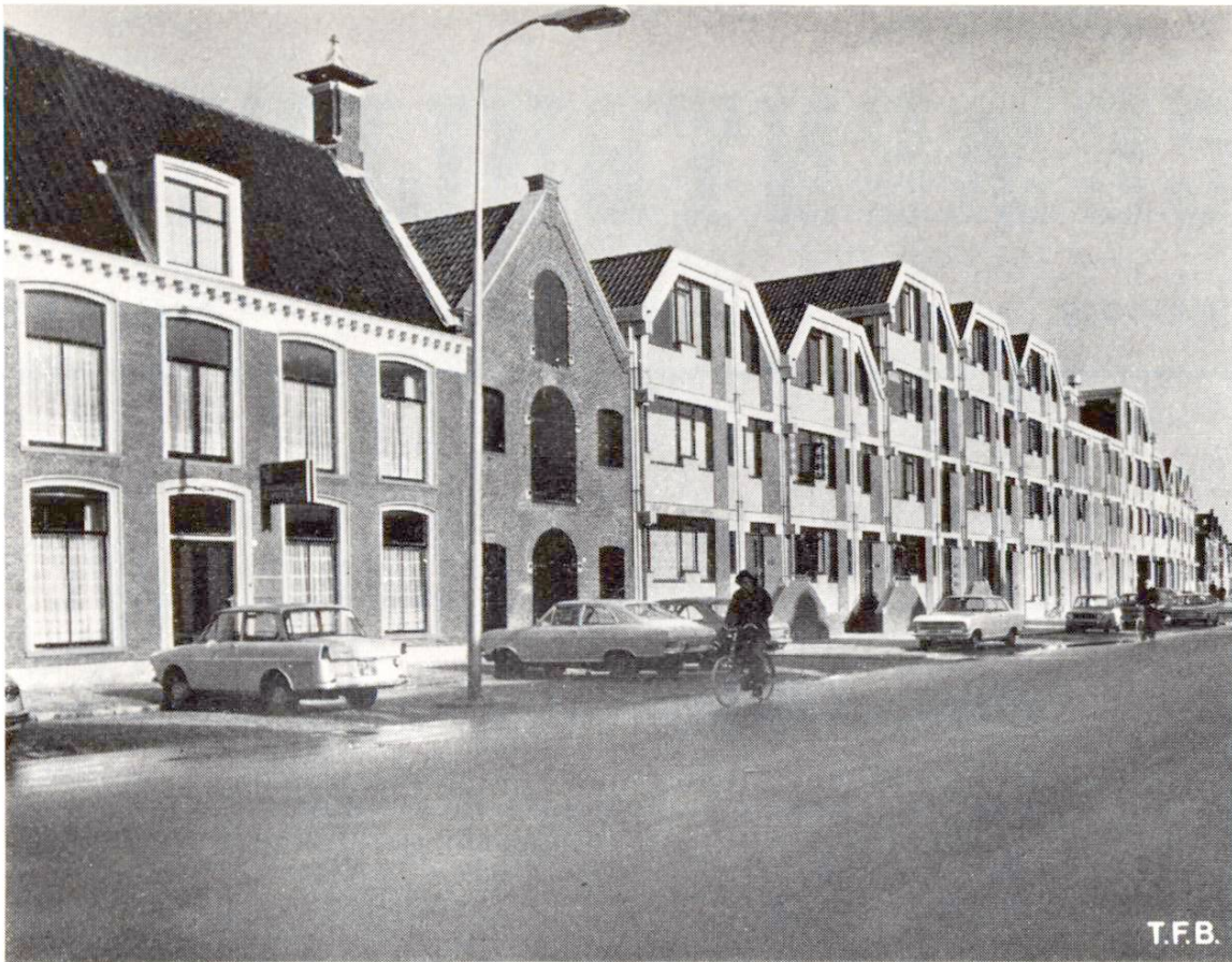
Abb. 1 Die Front des Neubaues fügt sich massstäblich gut in die Zeilen der alten Häuser entlang des ursprünglichen Kanals. Die moderne Bauweise stört das Bild nicht; die übereinstimmende Masstäblichkeit dominiert.
