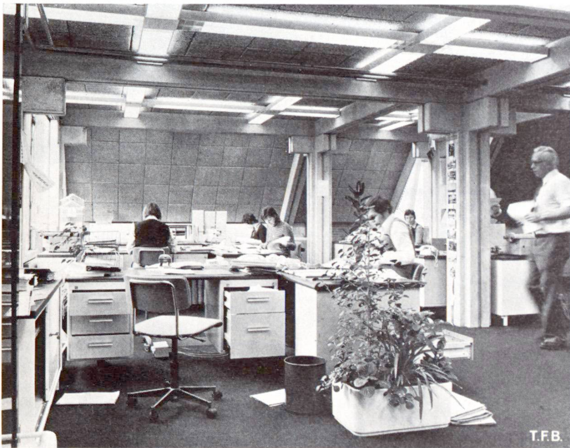
Abb. 4 Blick in einen der sehr wohnlichen Arbeitsräume. Ausfächung der Decken und schräggestellten Seitenwände mit Leichtbetonplatten.
