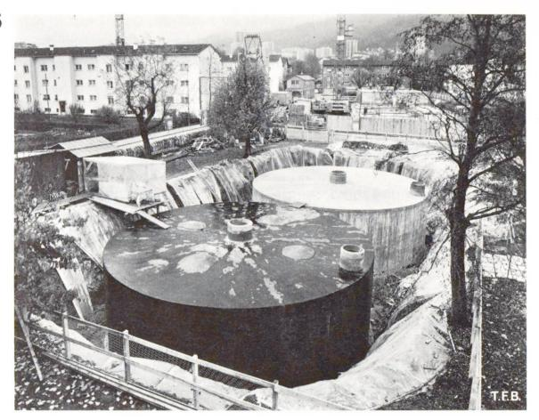
Abb. 1 Tankanlage für 1000 m³ Inhalt mit Polyester-Doppelmantel-Auskleidung für die gemeinnützige Baugenossenschaft Limmattal, Zürich.
