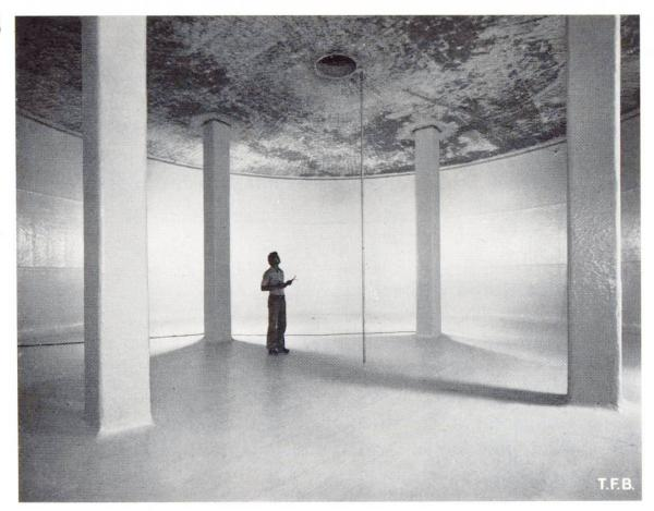
Abb. 3 Grosser Betontank mit Doppelmantel-Auskleidung fertiggestellt.
