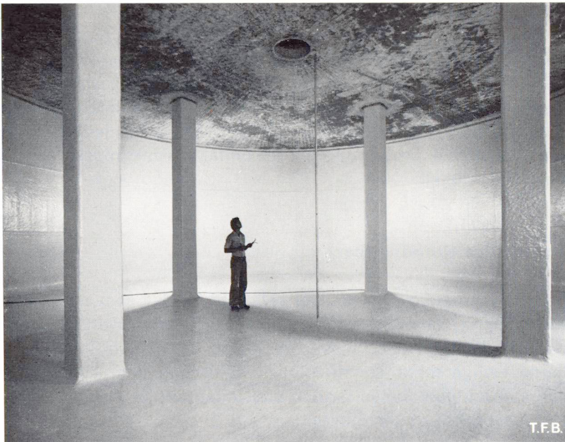
Abb. 3 Grosser Betontank mit Doppelmantel-Auskleidung fertiggestellt.
