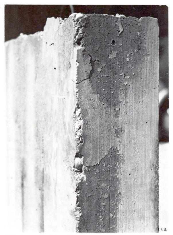
Abb. 4 Abstossen der Kante und Zementhautablösung als Folge von quellendem Schalungsholz bei «jungem Beton».
