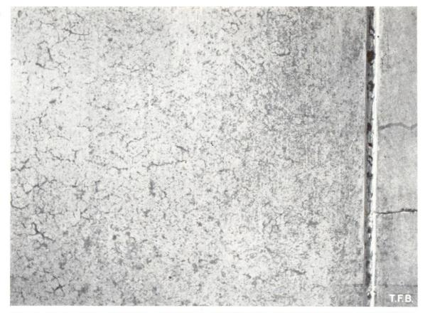
Abb. 2 Feines Netz von «Schrumpfrissen», die frühzeitig unter einer glatten, undurchlässigen Schalung entstanden sind. Am Rand haben sich weniger Risse gebildet.
