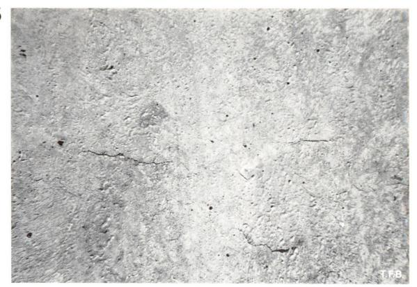
Abb. 3 «Setzungsrisse» infolge eines geringen Abgleitens von «jungem Beton» in der Schalung.
