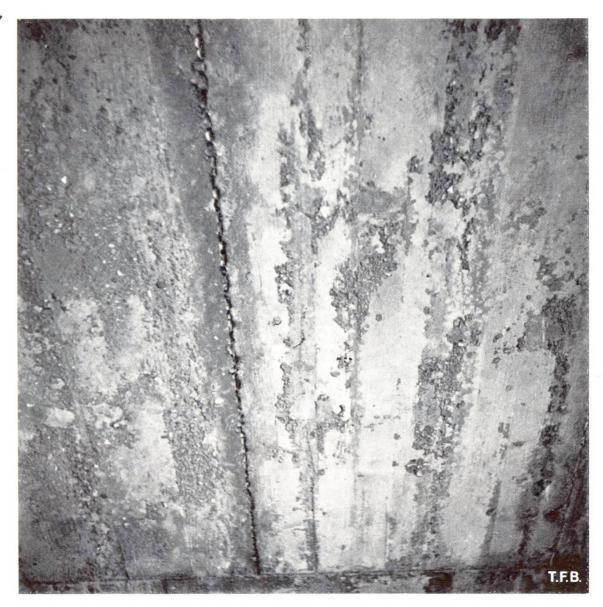
Abb. 5 Abscheren der Oberfläche von «jungem Beton» in einer Deckenschalung infolge von Durchbiegung oder Erschütterung.
