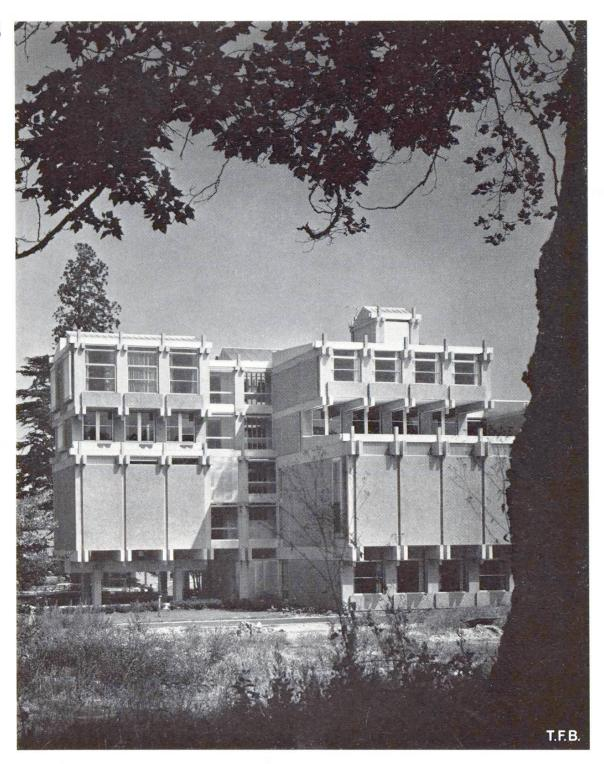
Die tragenden Doppelbalken sind im Kern des Gebäudes verankert. Dieser besteht aus einem steifen, längsgestellten Kasten aus Ortsbeton und enthält die Treppen, Gänge, Toiletten und Diensträume. Das Gebäude ist 120 m lang. Der Abstand der Trägerglieder beträgt einheitlich 2,4 m, und der Querschnitt der Stützen und Balken misst 200 × 600 mm. Die längeren und die stärker auskra-
