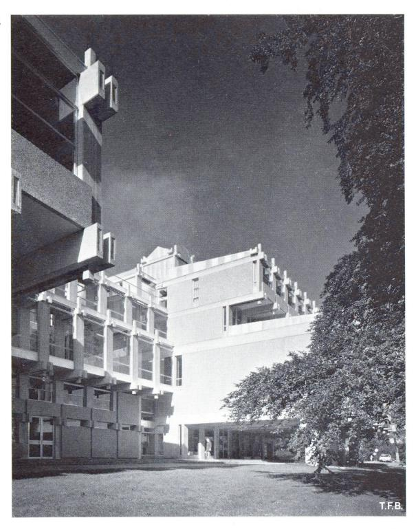
genden Balken sind vorgespannt. Die Oberfläche der Stabelemente ist glatt, der Beton schwach gelbbraun gefärbt. Die Fassadenplatten haben Waschbeton-Struktur mit dunkelbraunem bis gelblichem Rundkies. Das Gebäude wurde 1971 erstellt und kostete etwa 670 000 englische Pfund.
